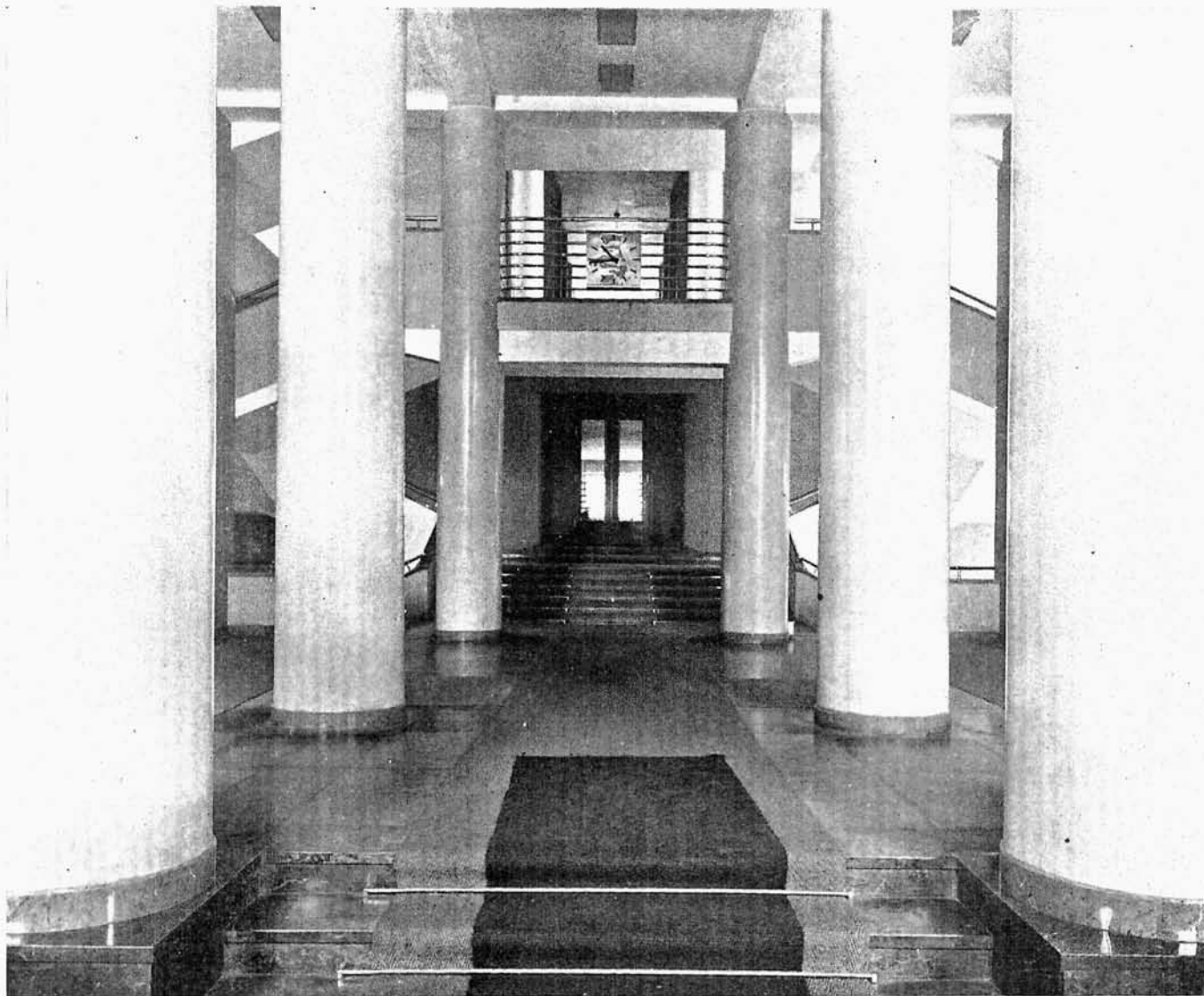
Hall wejściowy (widok od strony wejścia głównego).
