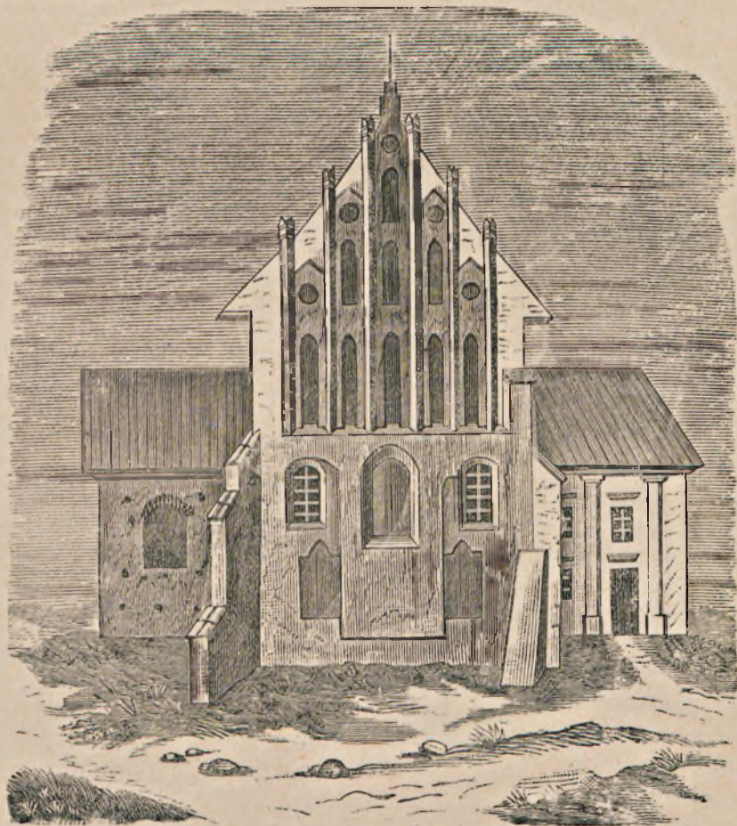
Tylne ściana Kościoła po-Franciszkańskiego (dziś Ewangelickiego) w Wyszogrodzie.
