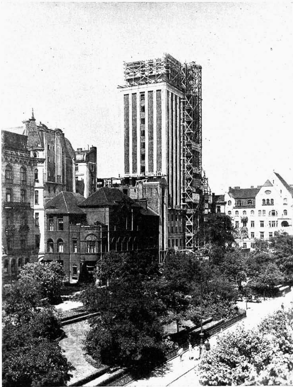
Widok ogólny w czasie budowy
