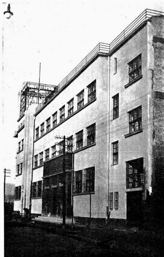
14 — 15. Gmach poczty w Częstochowie. Projekt. prof. dr. Adolf Szyszko-Bohusz (Kraków), Szczegóły i kierownictwo budowy: inż. Fryderyk Tadanier (Kraków).
