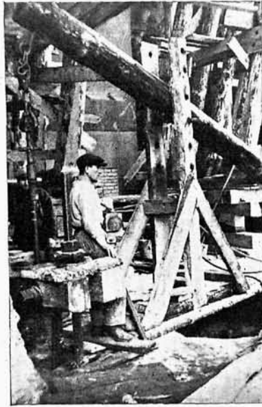
25. Rozbijanie kamienia, napotkanego w otworze, dłutem zapomocą balansu.
