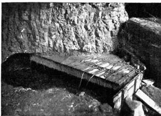
30. Obetonowywanie i podbijanie belek.
