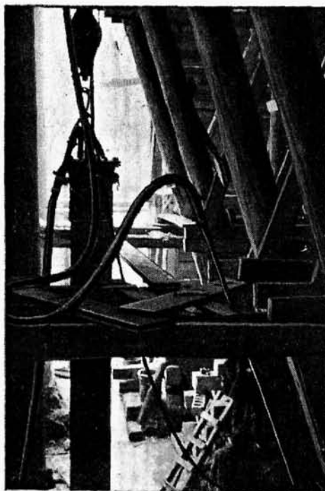
Pale pod fundamenty Bazyliki Wileńskiej, zbrojone, beton wtlaczany za pomocą sprężonego powietrza systemem M. Lempicki S. A. — 1933 r.
