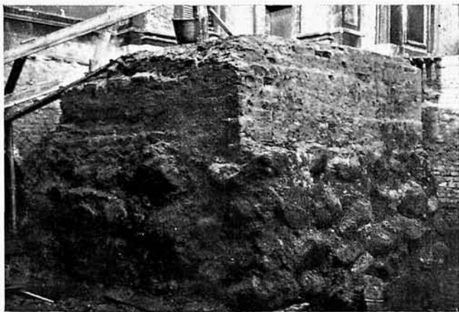
11. Blok średnicowy narożnika w kapł. św. Kazimierza, odpowiednik którego widać z zarysu fundamentów pod zakrystją (rys. 3).
