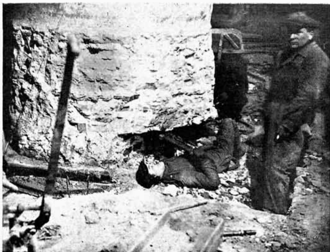
29. Podcinanie kolumny dla podprowadzenia belek dla utworzenia rusztu.
