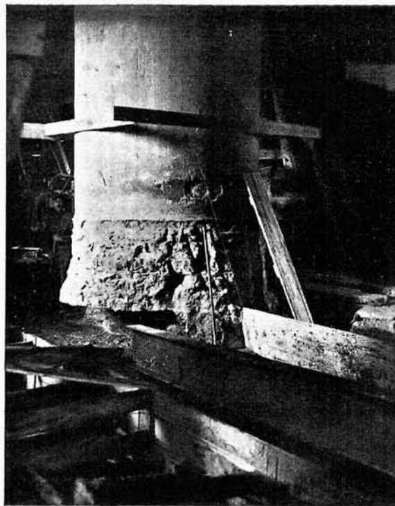
32. Wprowadzenie belki w podcięcie pod kolumną.
