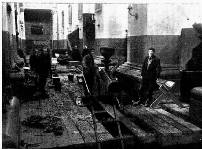
31. Zastrzyk zaczynu w mur filarowy przy krypcie kapitulnej.
