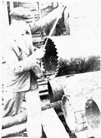
20. Rura uzębiona do wypilowania rusztów, ułożonych przez Gucewicza.
