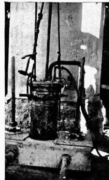
27 — 28. Wykonanie pali żelbetowych pneumatycznie, zapomocą sprężonego powietrza.
