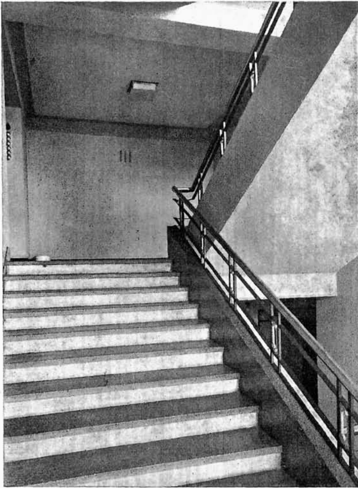
11 — 12. Arch. Teodor Bursze i A. Kowalski (Warszawa). Gmach Z. N. P. w Warszawie. Klatka schodowa w gmachu biurowym.
