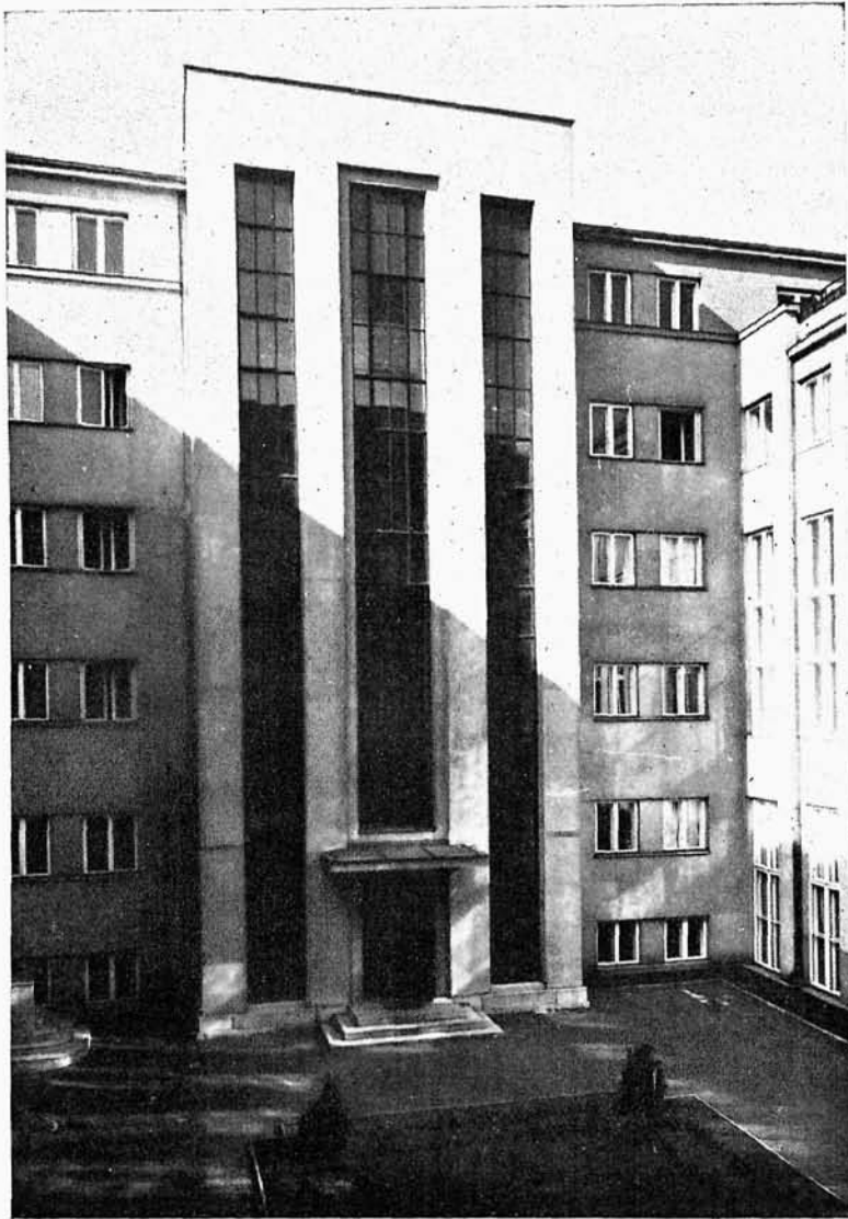
Klatka schodowa bursy.
