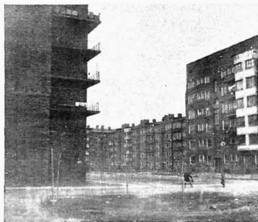
11—12. Olbrzymi dom, t. zw. „Ameryka” na Dangauerówce, również zw. „sow. central”. Kotłownia posiada 3 kominy, każdy 1 m 2 w przekroju. Budowa rozpoczęta i niedokończona, następnie kontynuowana przez bud. amerykańskich.
