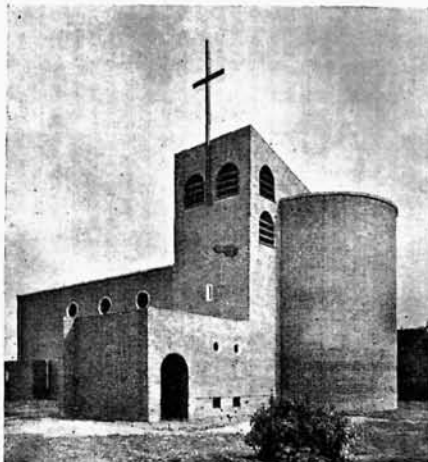
Arch.: C. G. Bense, J. Kamps i H. Amsinck. Kościół św. Pawła w Altonie. (Monatshefte für Baukunst).
