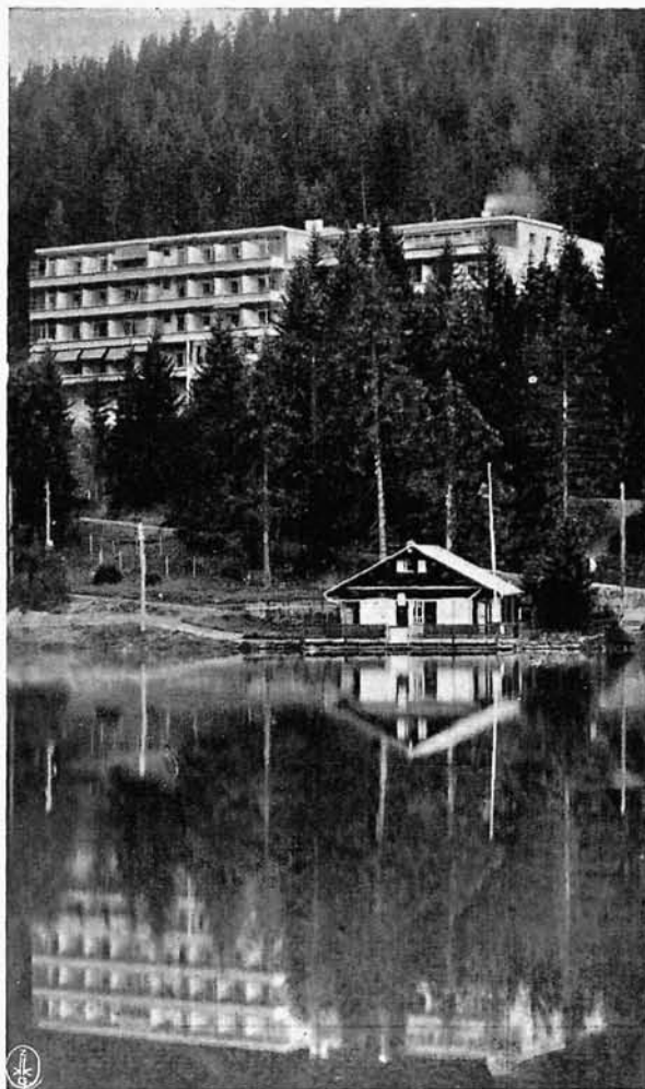
65—66. Arch.: Itten i Steiger. Sanatorium w Montanie. R. 1930.
