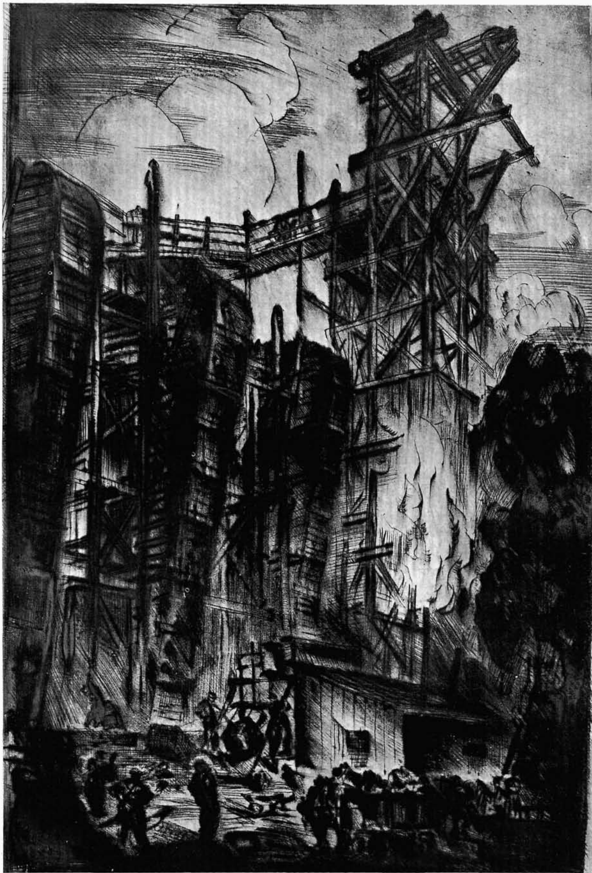
39. Arch. Edgar Norwerth (Warszawa). Hala ćwiczeń C. I. W. F. w trakcie budowy (suchoryt).
