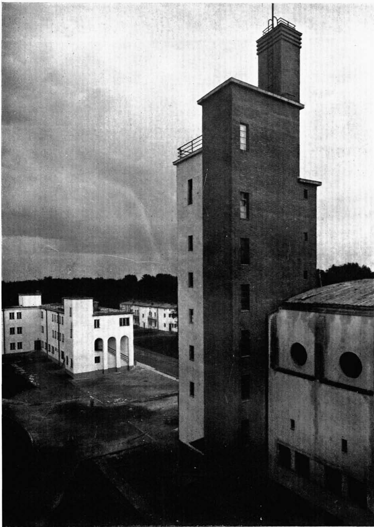
20. Arch. Edgar Norwerth (Warszawa). Pływalnia i wieża ciśnień C. I. W. F.
