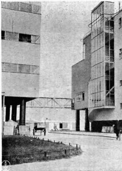
Przejście między fabryką a budynkiem biurowym.
