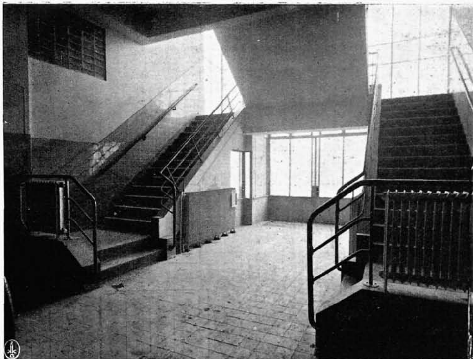
Rys. 24, 25. Arch. L. C. van der Vlugt & J. A. Brinkman. Fabryka Van Nelle w Rotterdamie (1930). Klatka schodowa na parterze i piętrze.
