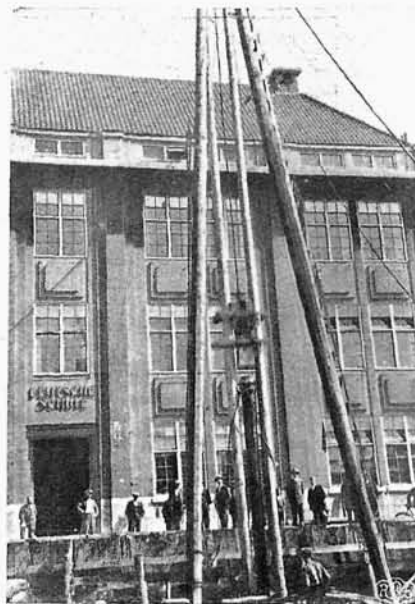
8—9. Dom towarowy w Rotterdamie. Pale i maszyny parowe.
