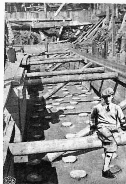
Fundamenty pod ścianą zewnętrzną.
