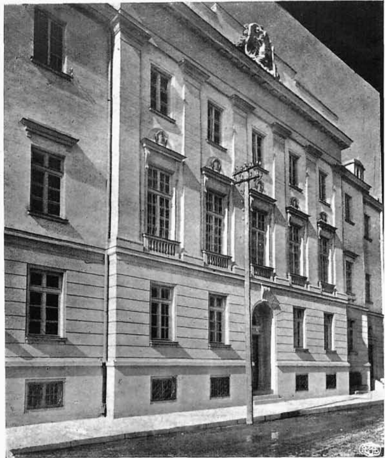
Fasada wyłożona wyprawą TERRAZYT (zakładów przemysłowych „TERRAZYT” w Warszawie. Instalacje wodne i ogrzew. centralnego wyk. f. „Instalator” (Warszawa). Projekt inst. oświetlenia elektrycznego wyk. f. „Wróblewski i Binzer, Inż.” (Warszawa). Skarbiec wykonała firma „Gustaw Gottschalk” (Warszawa).
