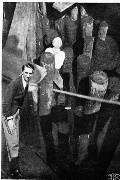
10. Dom towarowy w Rotterdamie. Obcinanie pali.
