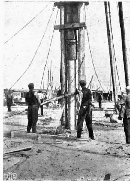
15. Wbijanie pala żelbetowego.
