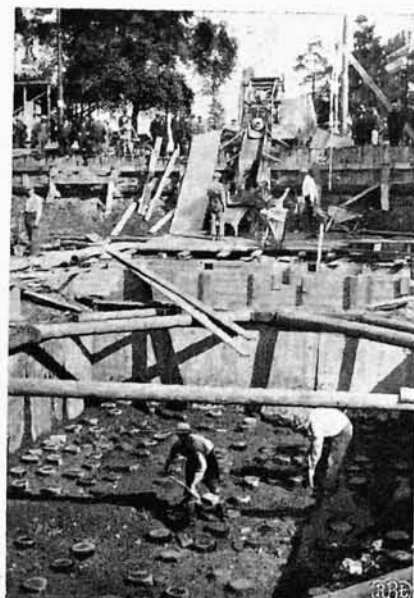
Fundamenty pod najgłębszą częścią budynku.
