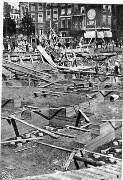
11—13. Budowa domu towarowego w Rotterdamie.
