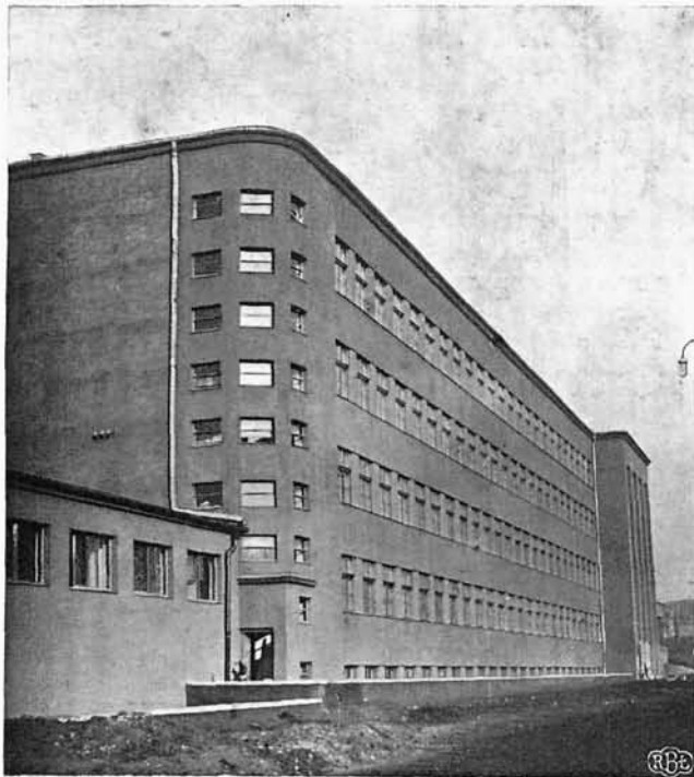
21-23. Magistrat Królewskiej Huty, inż. arch.: A. Olszewski i W. Soboń. Szkoła Handlowa w Królewskiej Hucie. Konstrukcje żelbetowe wyk. firma „Monier” (Katowice). Centralne ogrzewanie wyk. firma „E. Lamla” (Katowice).
