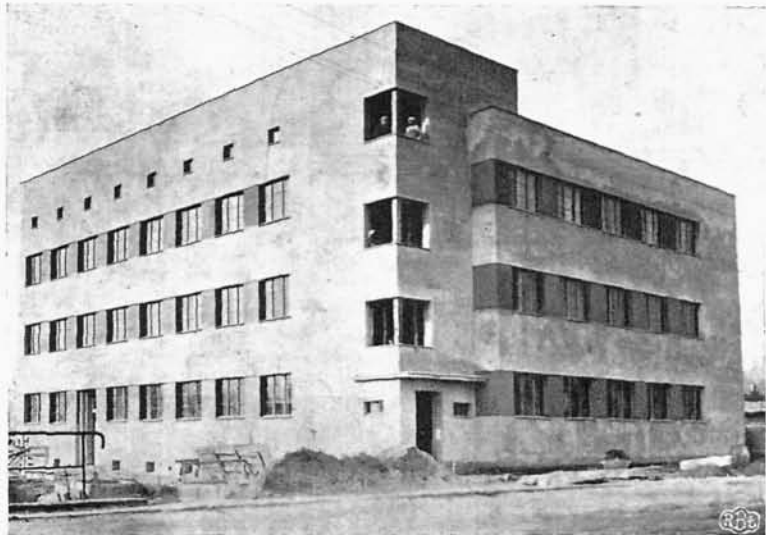
99-102. Urząd Wojewódzki w Katowicach. Inż. arch.: Tadeusz Kozłowski i Jan Bieńkowski (Katowice). Komenda Powiatowa i Komisarjat Policji w Pszczynie.
