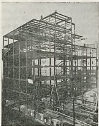
Ukończony szkielet spawany 6-cio piętrowego gmachu Urzędów Skarbowych w Katowicach przy ul. Zielonej.
