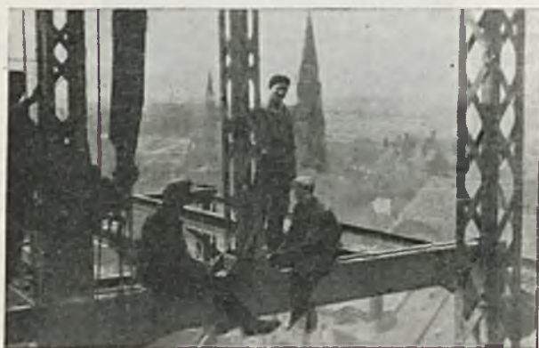
Fragment z montażu szkieletu śląskiego drapacza chmur w Katowicach.
