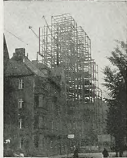
Szkielet 14-to piętrowego domu mieszkalnego i urzędów skarbowych w Katowicach przy ul. Zielonej. Właśc. budowy Śląski Urząd Wojewódzki.
