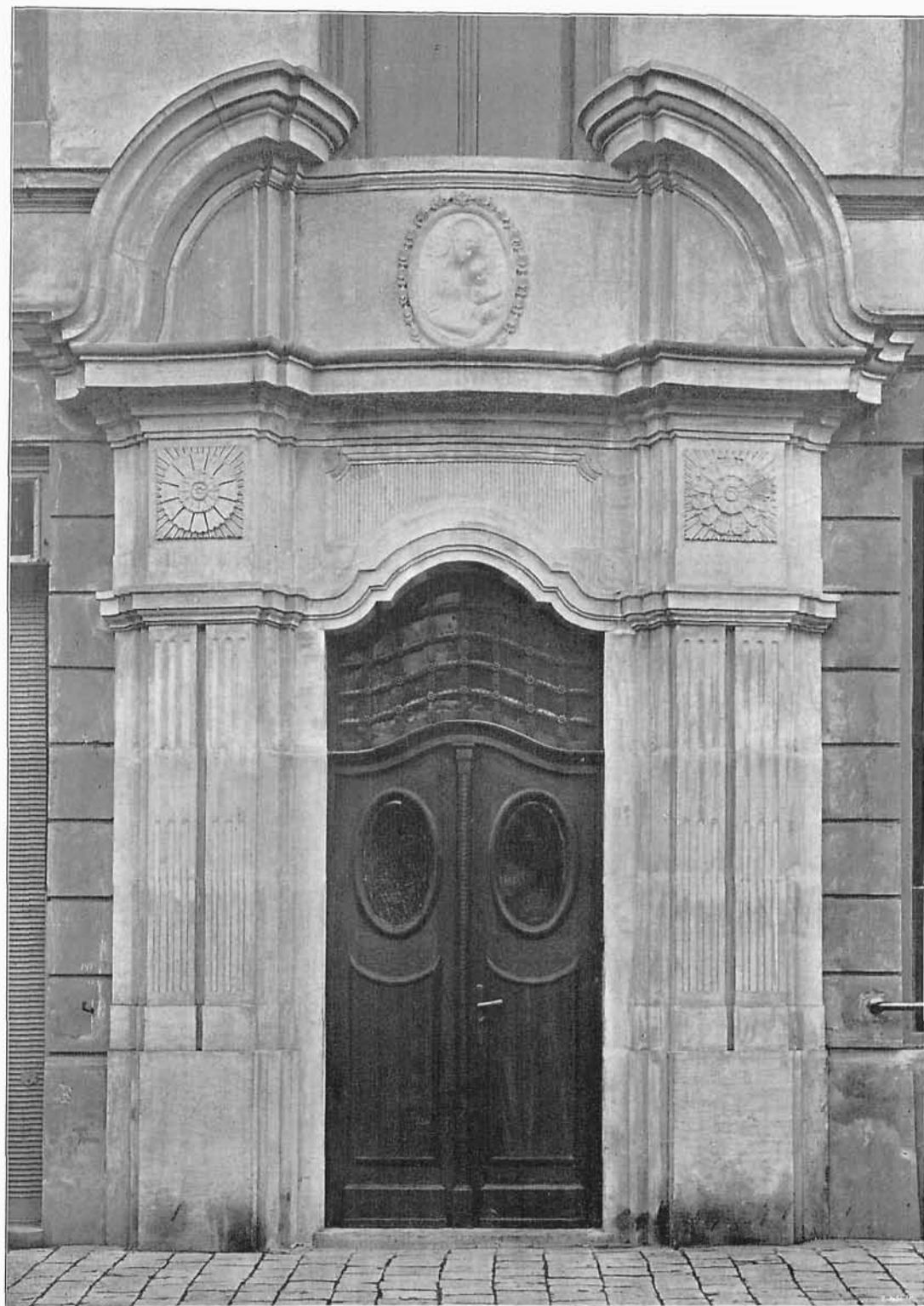
KAZIMIERZ WYCZYŃSKI: PORTAL DOMU pp. STRENKÓW OD STRONY UL. KARMELICKIEJ.
