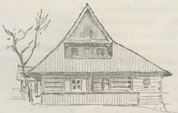
Rys. 14. Szczyt domu Krzeptowskiego z odgiętym rozłożystym asymetrycznym dachem.
