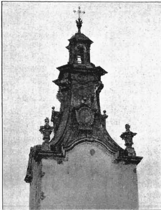
Katedra lwowska. Helm wieży, z wazonami kamiennymi, które mają być zamienione na blaszane.
