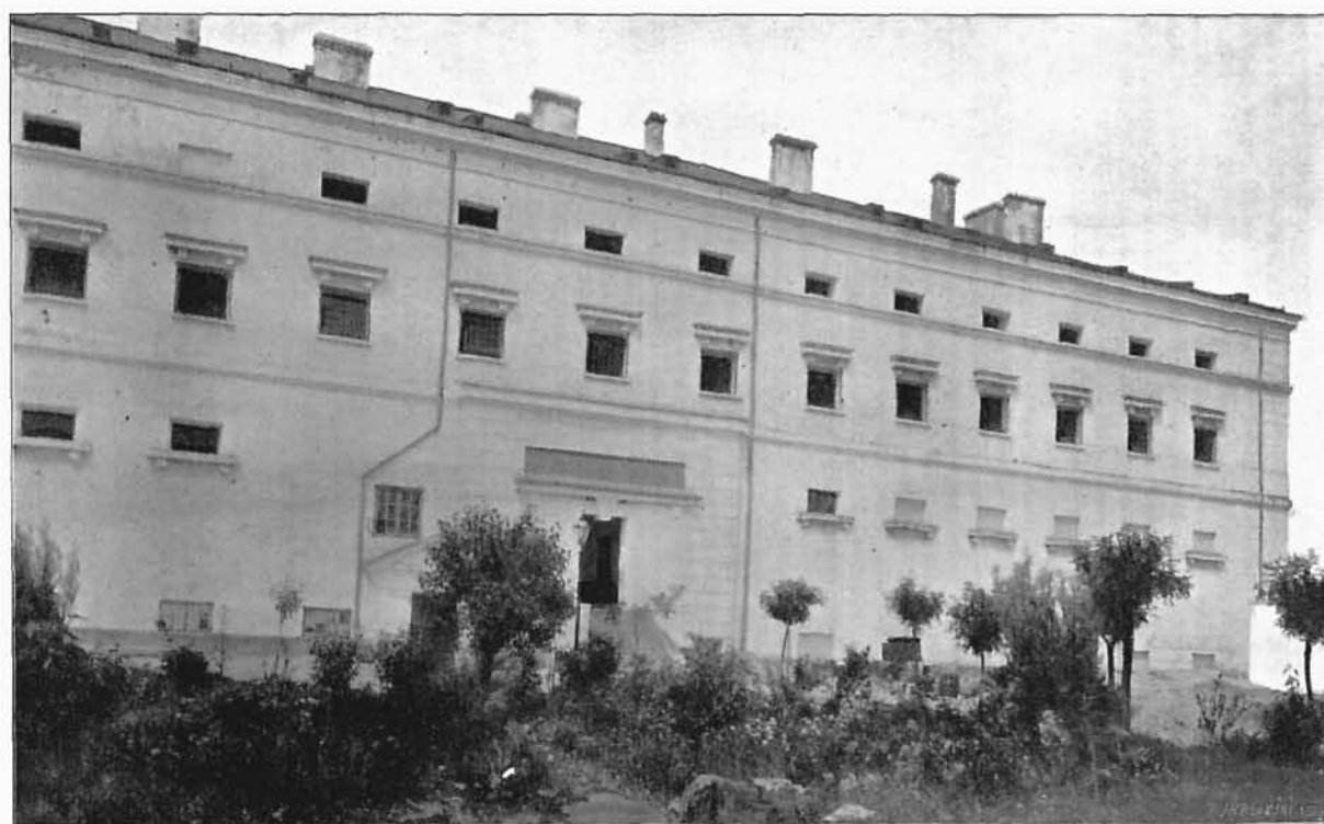
ZAMEK SANDOMIERSKI. SZCZEGÓŁ FASADY WSCHODNIEJ OD STRONY PODWÓRZA ZAMKOWEGO.
