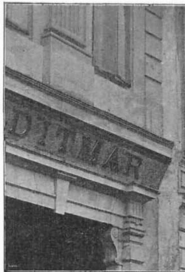
Restauracja domu p. Rippera w Rynku I. 22. — Ukośny fryz, jako rezultat zniszczenia szkarpy.
