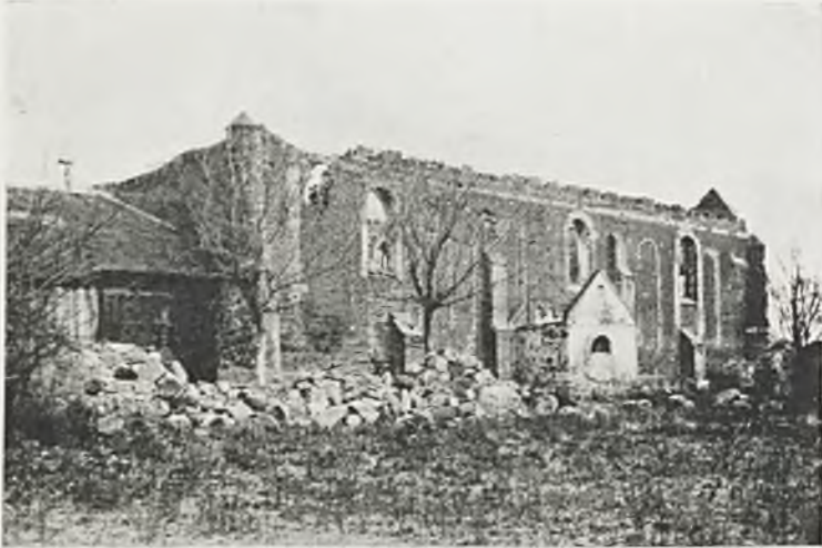
Ryc. 252. Pawłowo. Kościół parafjalny po zniszczeniu wojennym.
