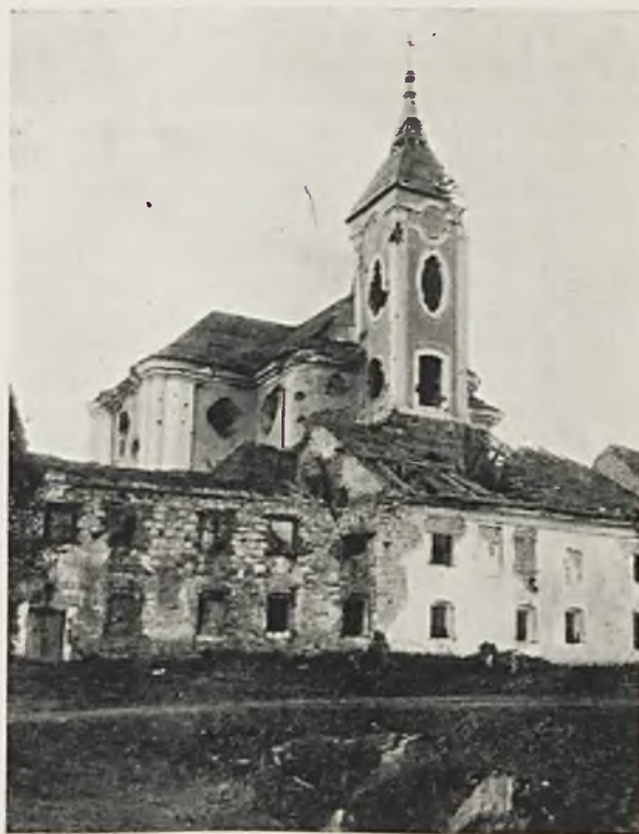
Ryc. 258. Sieciechów. Kościół i klasztor pobenedyktyński po zniszczeniu wojennym.
