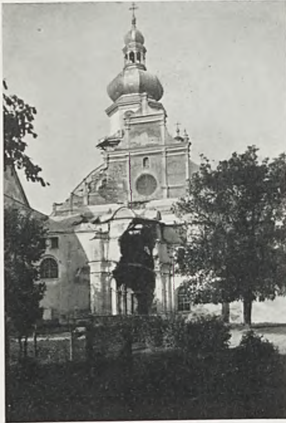
Ryc. 238 Sokal. Kościół OO. Bernardynów po zniszczeniu wojennym.
