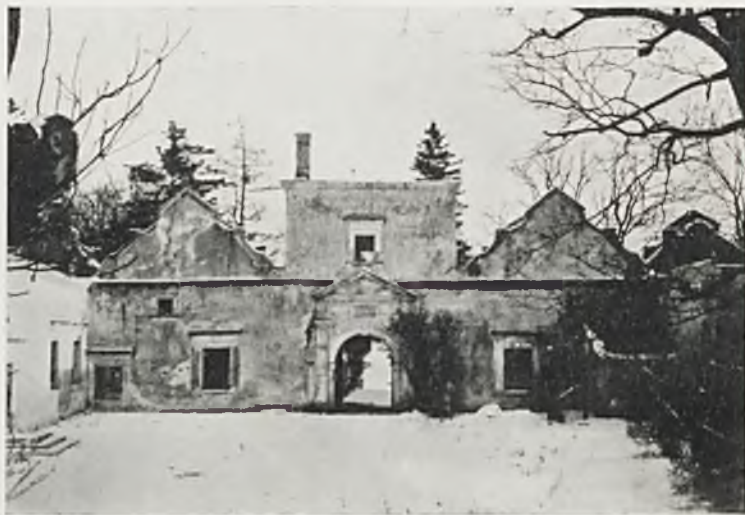
Ryc. 246. Świrz. Zamek po zniszczeniu wojennym.
