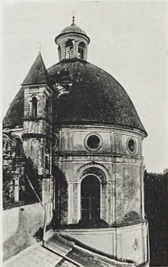
Ryc. 241. Krasiczyn. Zamek. Kaplica po zniszczeniu wojennym.
