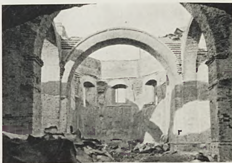
Ryc. 237. Magierów. Kościół po zniszczeniu wojennem.
