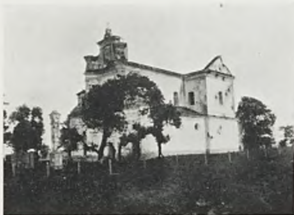
Ryc. 263. Czartorysk. Kościół parafjalny po zniszczeniu wojennym.
