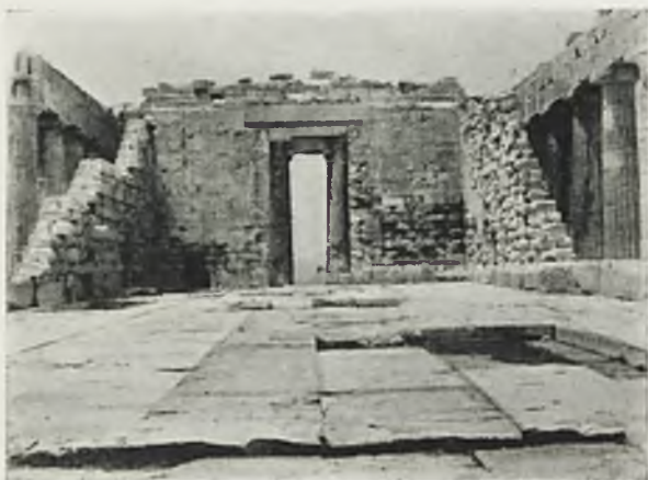
Ryc. 389. Partenon. Wnętrze. Część zachodnia po usunięciu łuku bramy, który zastąpiono architrawem. Wygląd z czerwca 1930.
