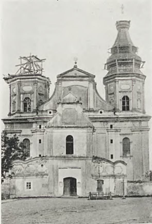
Ryc. 240. Uhnów. Kościół parafjalny w czasie odbudowy po zniszczeniu wojennym.
