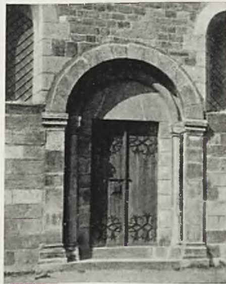
Ryc. 290. Kruszwica. Kolegiata. Portal boczny.
