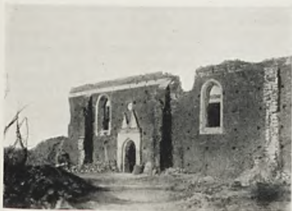
Ryc. 251. Kozłowie Biskupie. Kościół parafjalny po zniszczeniu wojennem.
