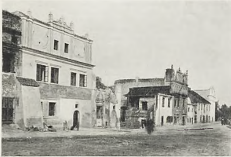
Ryc. 259. Kazimierz n/Wisłą. Ulica Senatorska. Domy zniszczone w czasie wojny.
