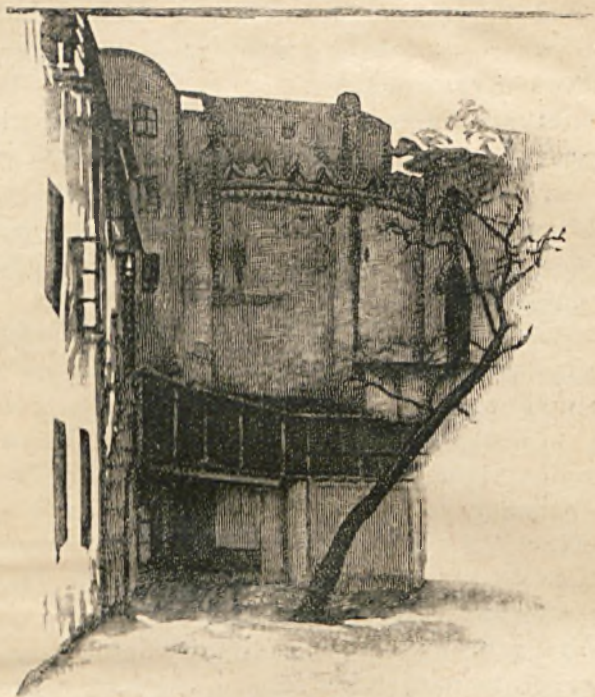
Mury dawnej baszty, widziane z podwórza przy ul. Mostowej Nr. 3.
