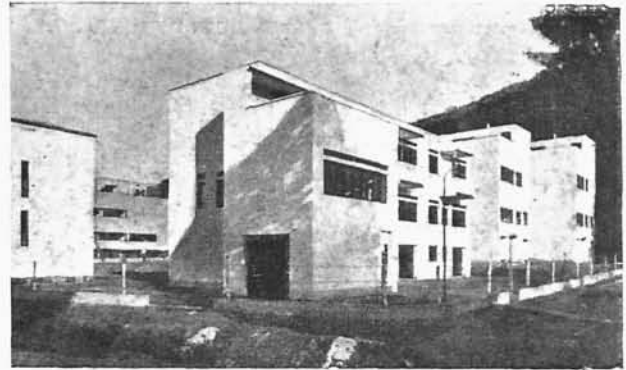
Ryc. 22. Arch. A. Wiesner — dom Nr. 16; arch. B. Fuchs — dom Nr. 1, 2, 3; arch. J. Štěpánek — dom Nr. 4, 5.
