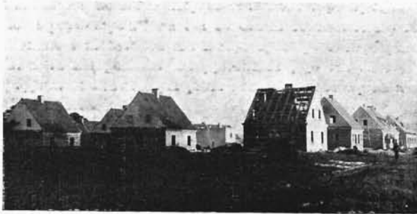
Ryc. 24 — 26. Ogólny widok zabudowań osad rybackich na Helu.
