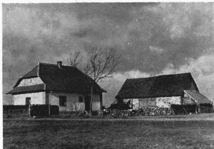
Domek z gliny na szkielecie murowanym. Kubatura — 310 m 3 , koszt budowy 3.500 zł. Budynek inwentarski z kamienia polnego. Arch. Paweł Wędrzicki (Warszawa). Zabudowa osad przez P. B. R. w pow. kutnowskim. Zagroda osadnika w folwarku Długoleka, klucz Strzelce.
