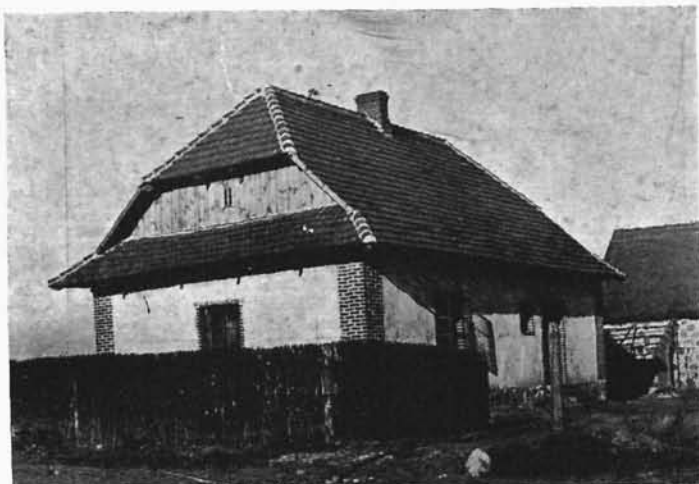
Domek z gliny na szkielecie murowanym. Kubatura — 310 m 3 , koszt budowy 3.500 zł. Budynek inwentarski z kamienia polnego. Arch. Paweł Wędrzicki (Warszawa). Zabudowa osad przez P. B. R. w pow. kutnowskim. Zagroda osadnika w folwarku Długoleka, klucz Strzelce.
