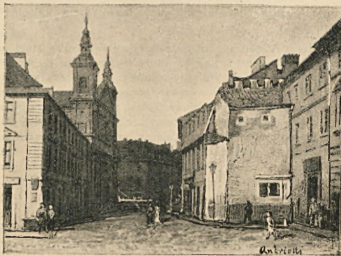
Stare mury przy ulicy Nowomiejskiej, z widokiem na kościół Św. Ducha.
