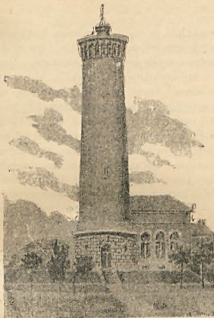
Wieża ciśnion na stacyi filtrów.
