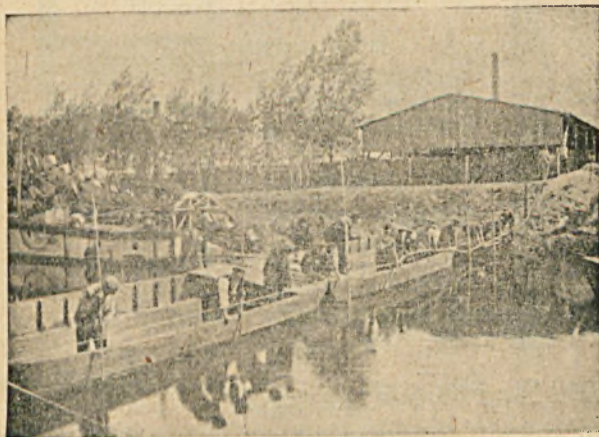
Rys. 40. Układanie kabla przez małą rzekę.
