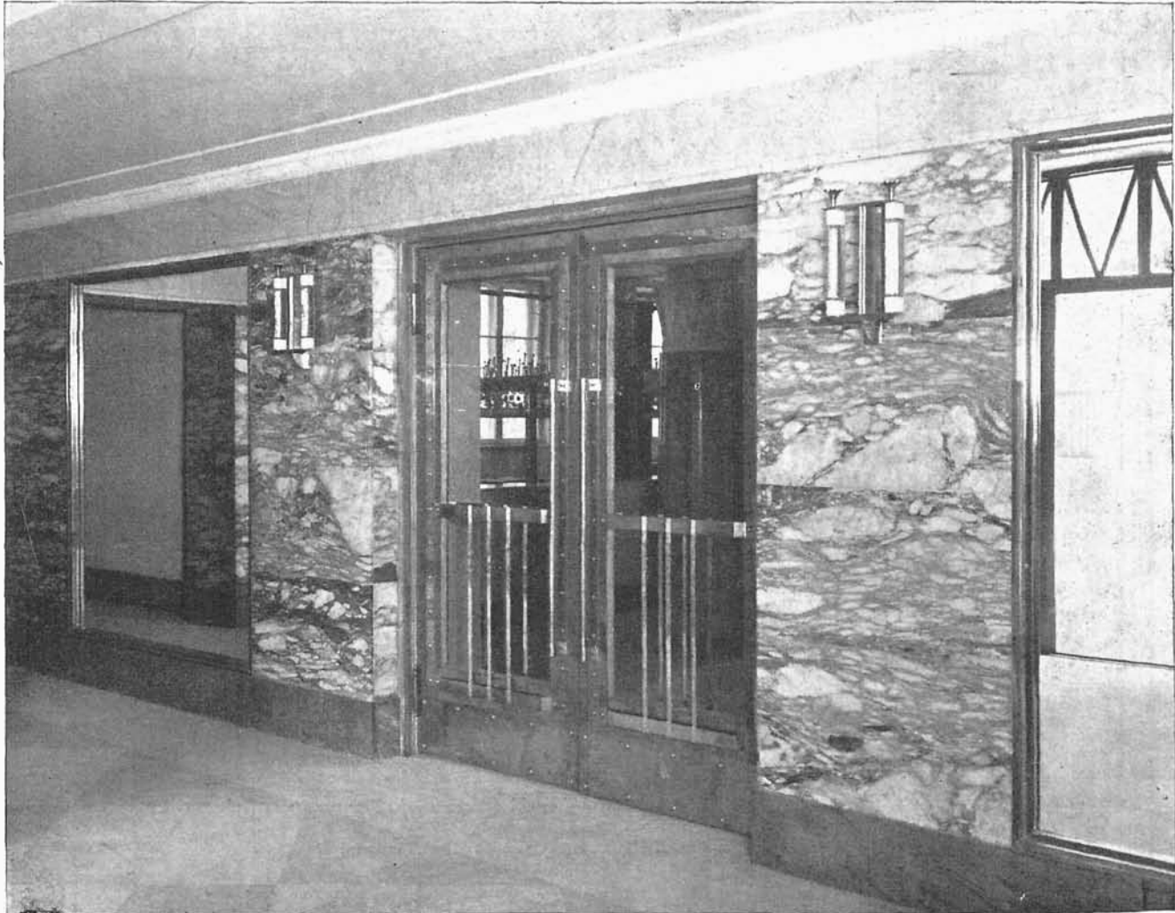
Ryc. 8. Arch. Romuald Miller i art. mal. Wojciech Jastrzębowski (Warszawa). Westibul teatralny gmachu Z. Z. K. w Warszawie. Drzwi do szatni. Okucie drzwi mosiądzem wyk. firma „A. Morantowicz”. Posadzki, ściany i kominki marmurowe wyk. firma „Jan Fedorowicz”. Drzwi jesionowe wyk. firma „Jan Trzcziński i S-ka”.
