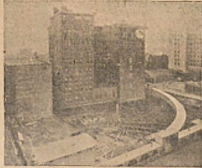
Rys. 14. 12 listopada. Budynek stał wreszcie na nowym miejscu.
