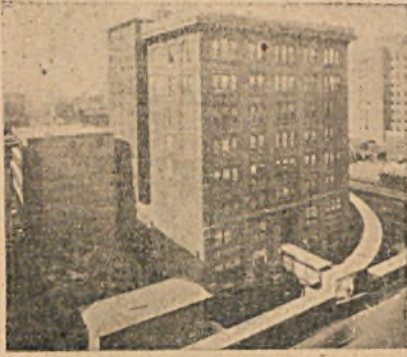
Rys. 6. 25 października. Rozpoczęcie obrotu budynku o 90^\circ do położenia „3” na rys. 1.
