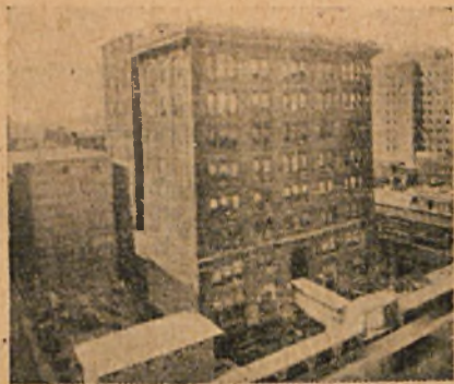
Rys. 5. 18 października. Budynek przesunięty o 16 m. wzdłuż ul. Meridian zajął położenie oznaczone „2” na rys. 1.
