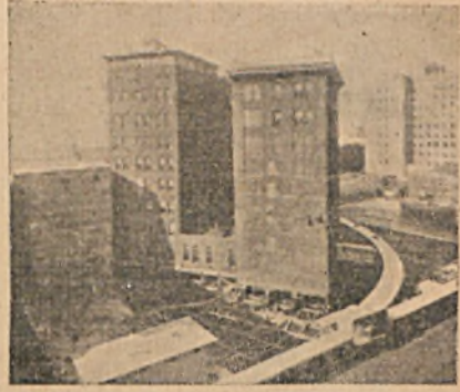
Rys. 9. 1 listopada. Wykonanie \frac{1}{2} obrotu.
