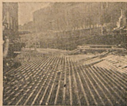
Rys. 15. Liny ciągnące fasadę północną.
