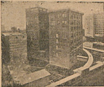
Rys. 8. 30 października. Uskutecznienie \frac{1}{3} obrotu.
