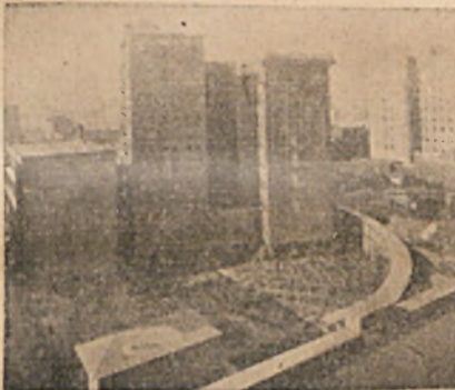
Rys. 13. 11 listopada. Jeszcze parę metrów do przesunięcia.
