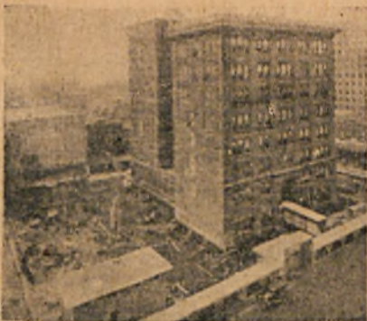
Rys. 4. 14 października. Budynek jest przygotowany do przesuwania wzdłuż ulicy Meridian.
