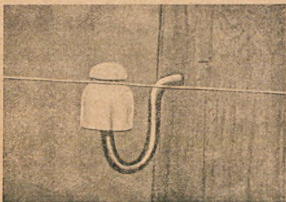
Rys. 3. Wykonanie przewiązki specjalnej. Czynność 1: przykładanie przewodu liniowego do izolatora
