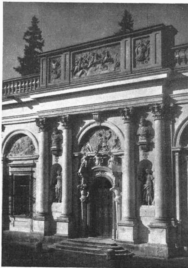
FIG. 42. ŚRÓDKOWY RYZALIT LEWEGO SKRZYDŁA PALACU
