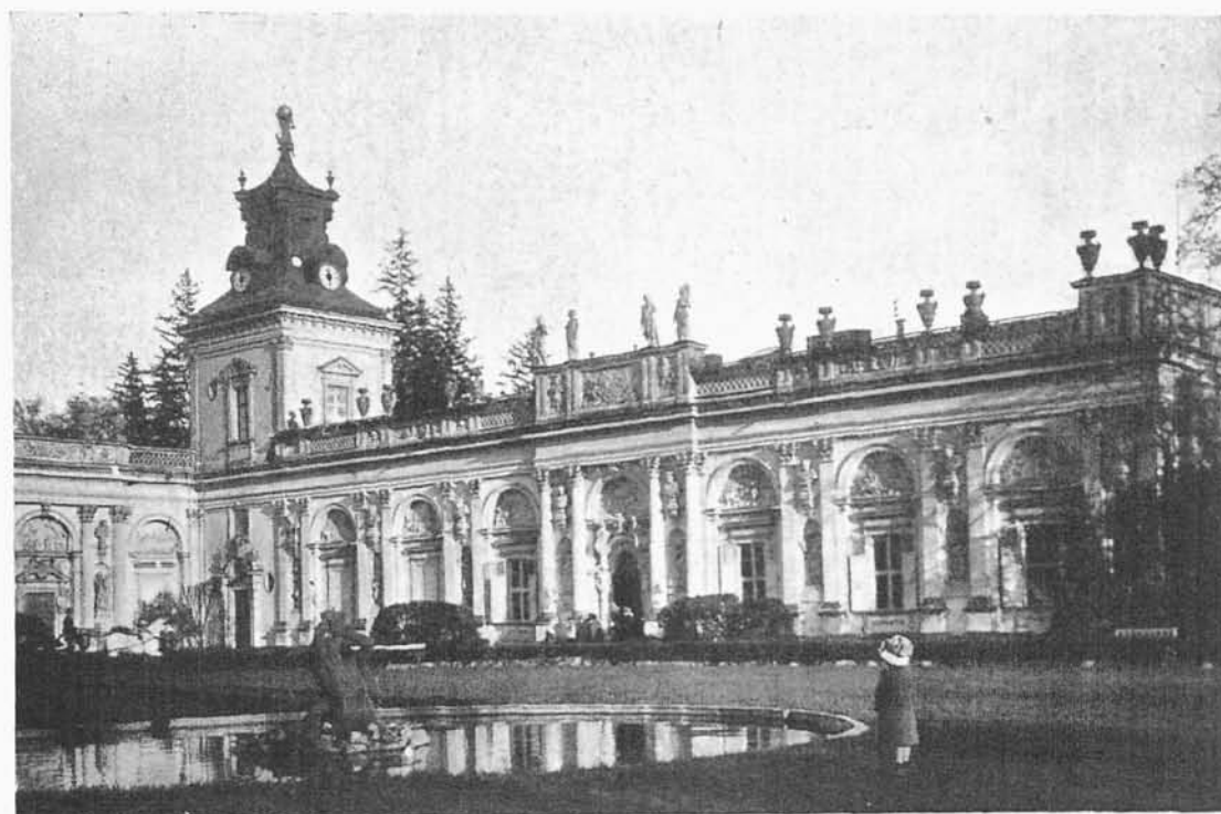
FIG. 33. PRAWY SKRZYDŁO PALACU Stan przed restauracją z dachem, opartym na balustradzie i z wazonami blaszanymi
