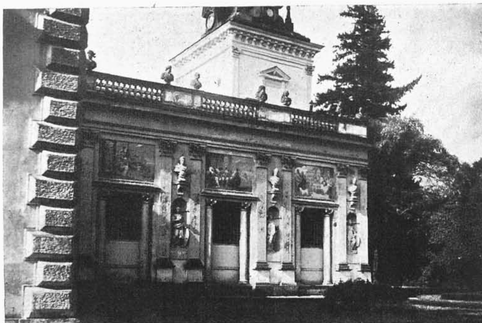
FIG. 19. GALERIA BOCZNA (PÓLNOCNA) PALACU OD STRONY PARKU Architektura przypuszczalnie z czasów II okresu budowy Sobieskiego; dziś stanowi zakrytą galerję obrazów
