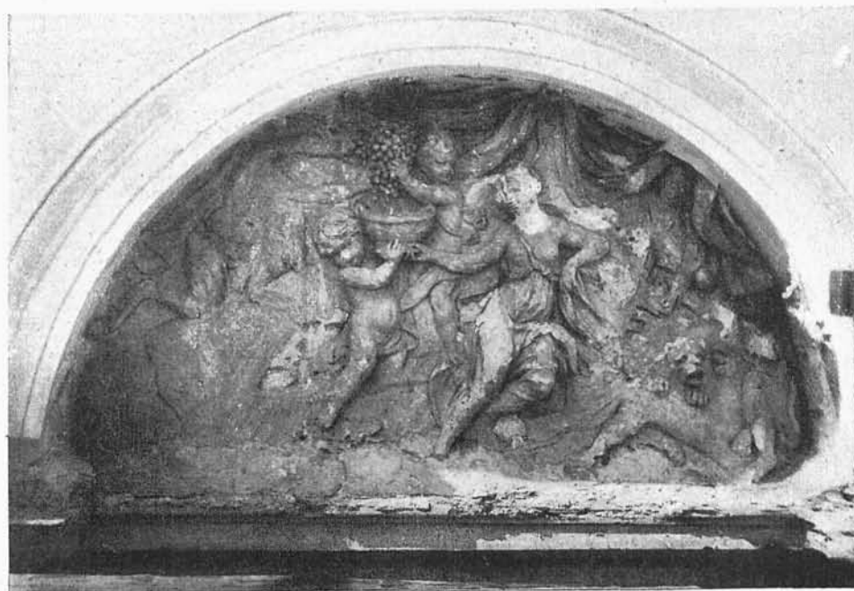
FIG. 38 i 39. PŁASKORZEŻBY W LUKACH ARCHIWOLT LEWEGO SKRZYDŁA PALACU Stan przed restauracją
