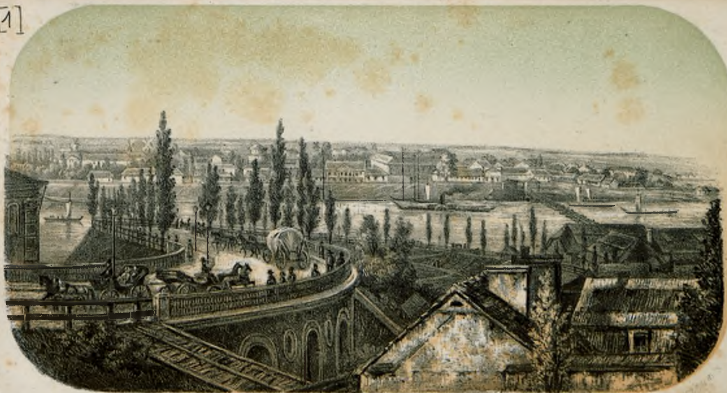
WIDOK PRAGI Z NOWEGO ZLAZBU | VUE DE PRAGUE PRISE DE LA NOUVELLE ROUTE.
