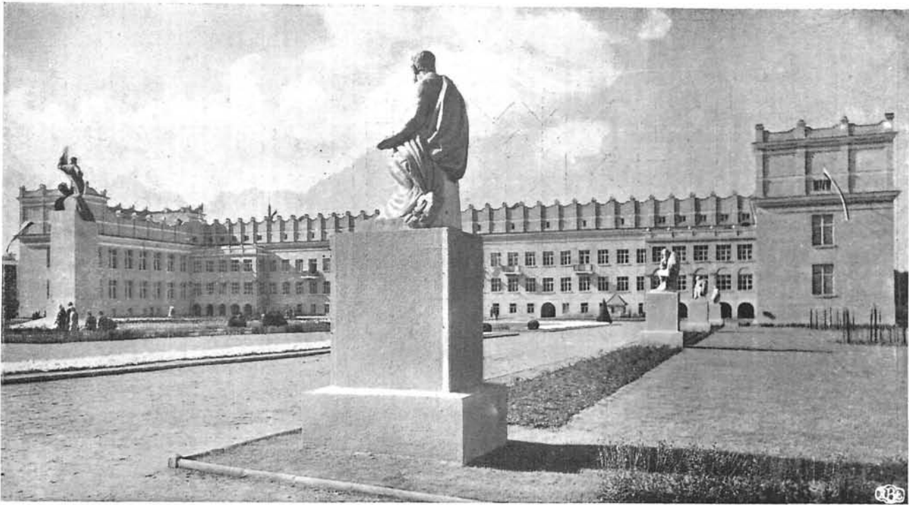
10. Architekt Roger Sławski (Poznań). Pałac Rządowy na Powszechnej Wystawie Krajowej w Poznaniu od strony dziedzińca. Teren B.
