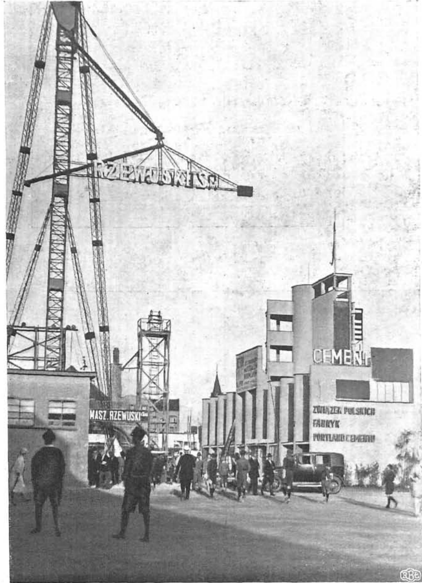
31-33. Arch.: B. Lachert i J. Szanajca (W-wa). Pawilon Centrocementu na terenie E.
