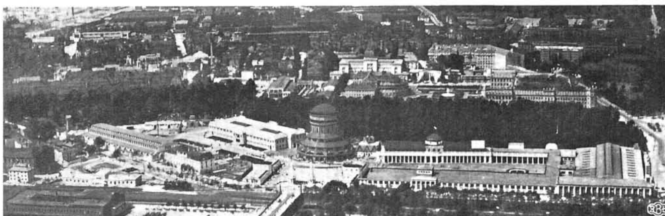
8. Widok z lotu ptaka terenu A. Z prawej strony Hala Centralna przemysłu metalowego W środku wieża.
