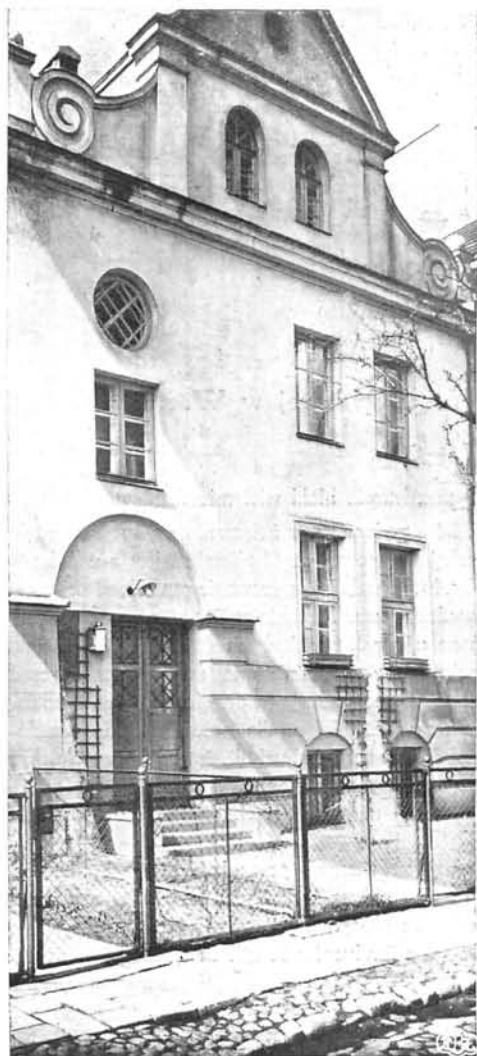
Fragment domu od ul. Lekarskiej
