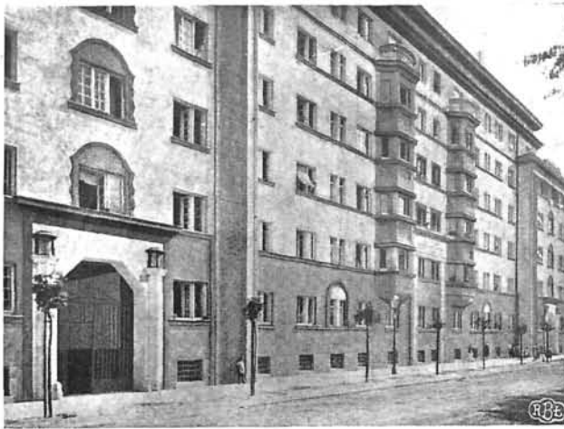
Rys. 24. „Kaisermühlendamm“. Widok od strony bulwaru.
