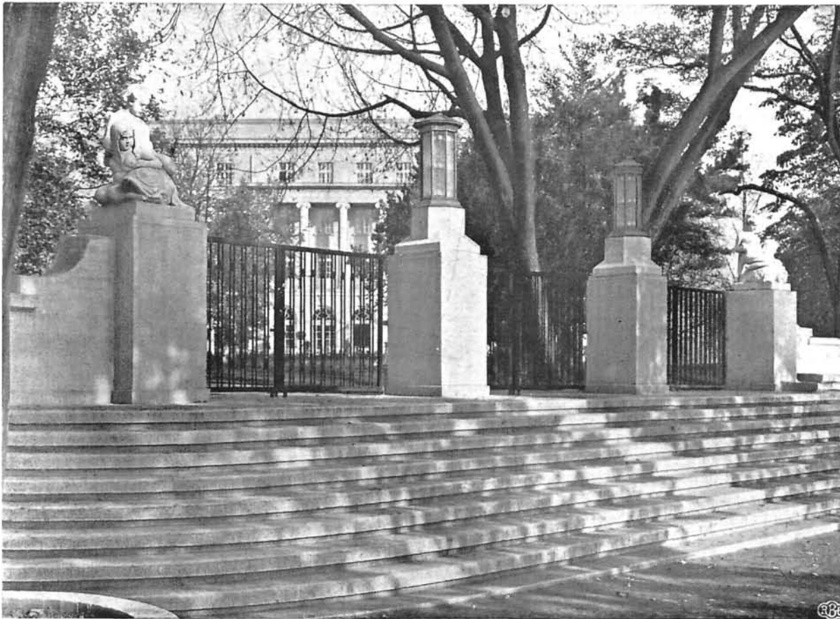
Rys. 1. Miejski Urząd Bud. Naz. w Poznaniu. Arch.: Kazimierz Ruciński i Stanisław Kirkin (Poznań) Wejście monumentalne do Parku Wilsona w Poznaniu. Okucie żelazne bramy wyk. firma „Fr. Radomski” (Poznań).
