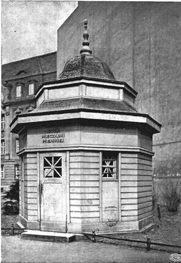
Rys. 97. Miejski Urz. Bud. Naz. w Poznaniu. Arch.: K. Ruciński i St. Kirkin (Poznań). Kiosk mleczarni miejskiej. Wybud. firma „Jan Łęgowski” (Poznań).
