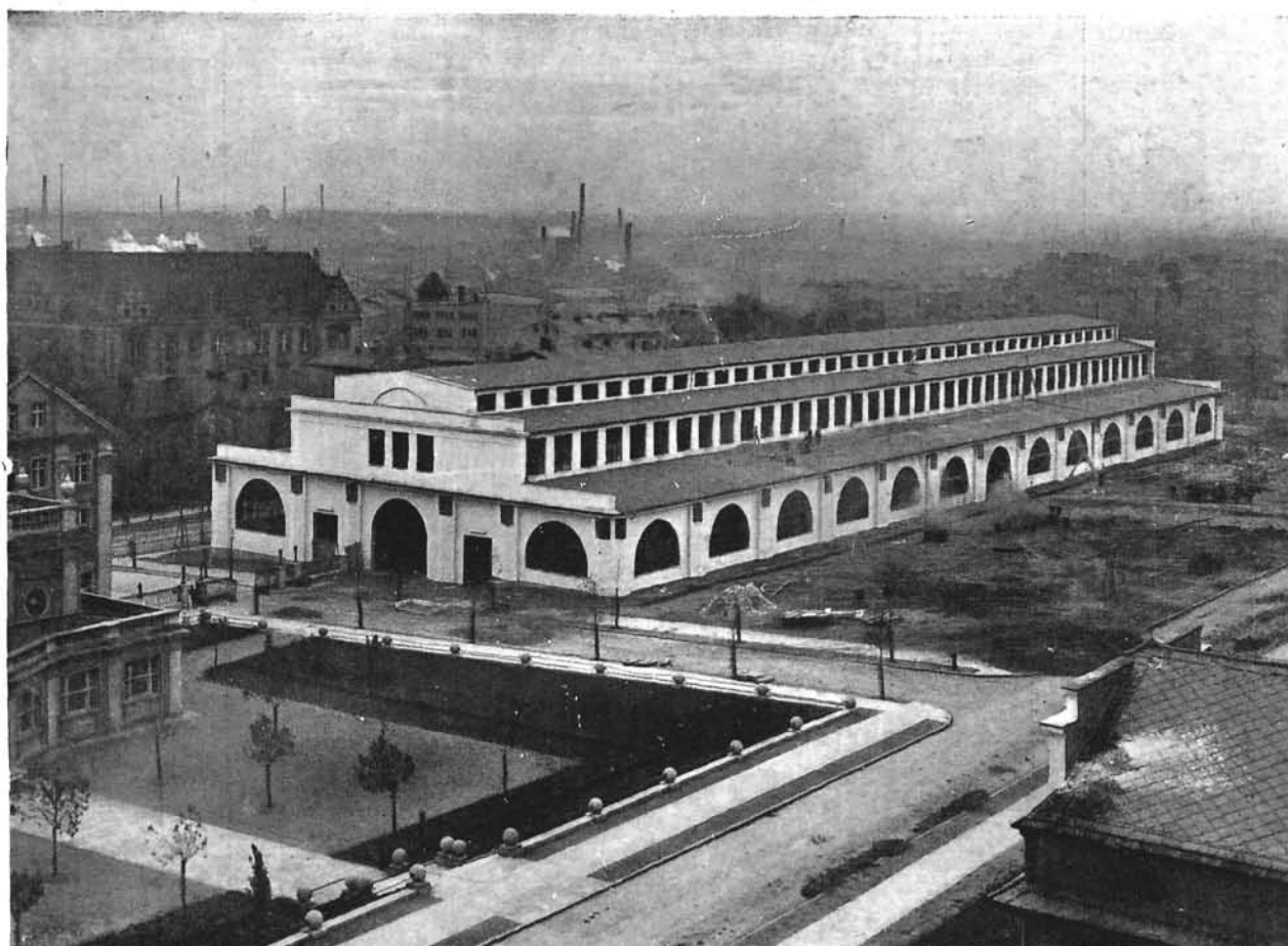
Ryc. 16. Widok Hali Ciężkiego Przemysłu z lotu ptaka.
