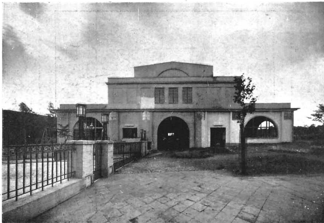
Ryc. 15. Arch. Roger Sławski (Poznań). Hala Ciężkiego Przemysłu na P. W. K. w Poznaniu (ryc. 10 i 11). Hala wykonana przez firmy „Tibr” (Warszawa) i „Monier” (Śląsk).
