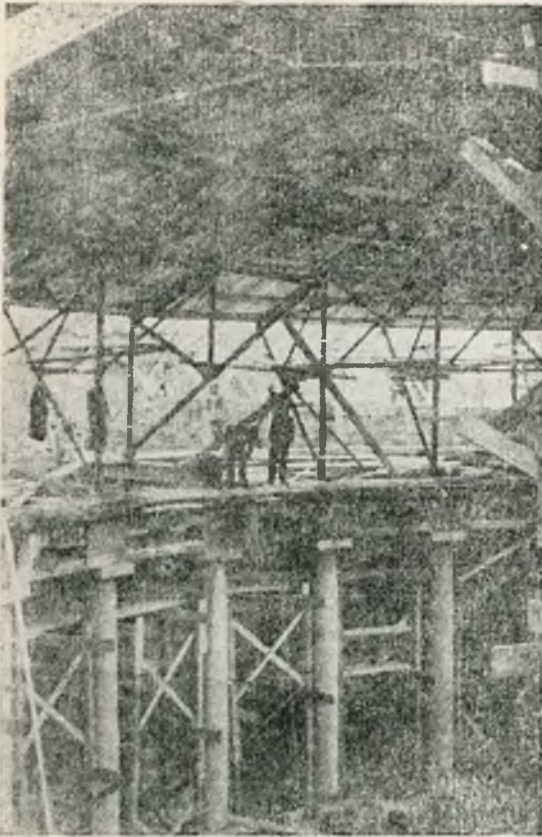
Wnętrze Sali Sejmowej podczas odbudowy. Okrywanie deskowaniem stalowej konstrukcji dachowej.
