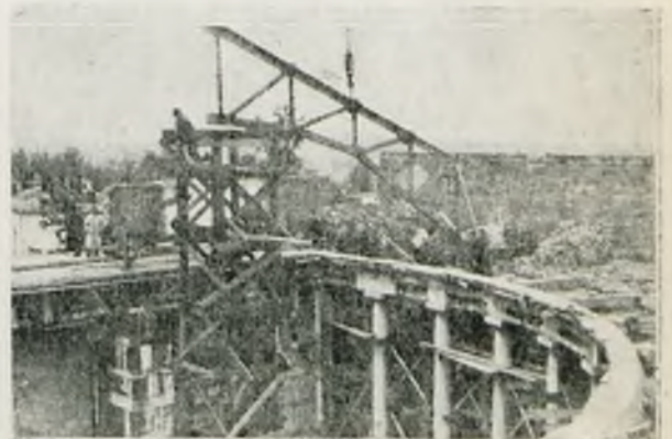
Założenie pierwszego dźwigara stalowej konstrukcji dachowej.
