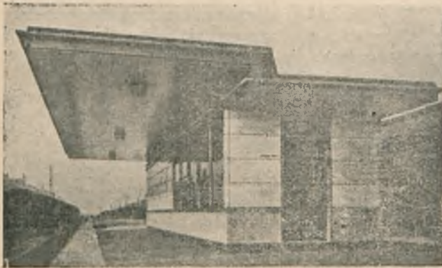
Widok ogólny prefabrykowanej poczekalni peronowej, wykonanej w Anglii.
