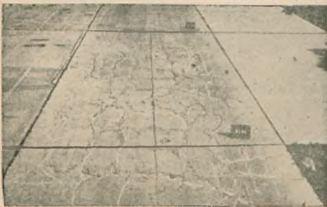
Fig. 2. Z doświadczeń w Lockburne. Płyta betonowa grub. 25 cm na 30 cm, podkładzi z piasku i żwiru po 400 przejeździach koła o obc. 25 ton.
