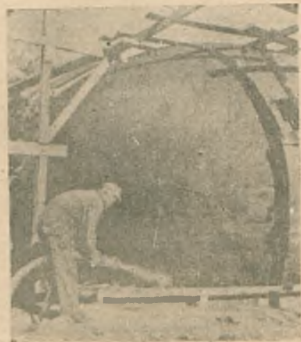
Fig. 5. Natryskiwanie (torkretowanie) konstrukcji domu na szalowaniu balonowym.
