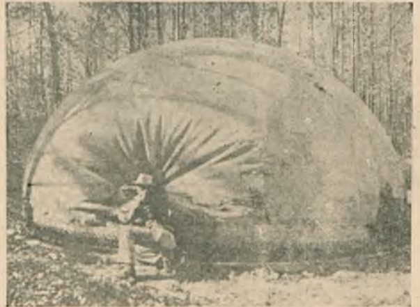
Fig. 4. Szalowanie betonowe domu półkulistego.
