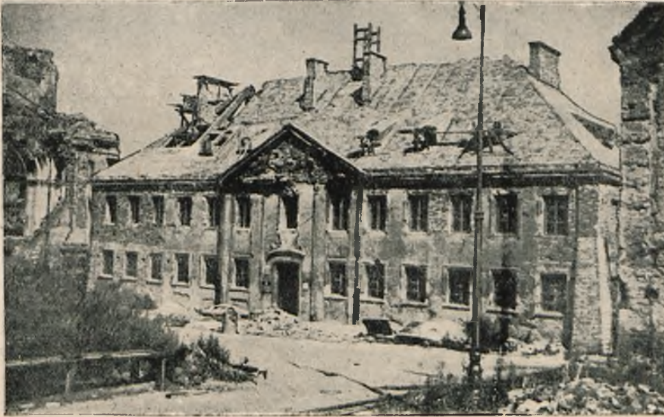
Klasztor Sióstr Sakramentek na Nowym Mieście — odbudowa — rok 1946
