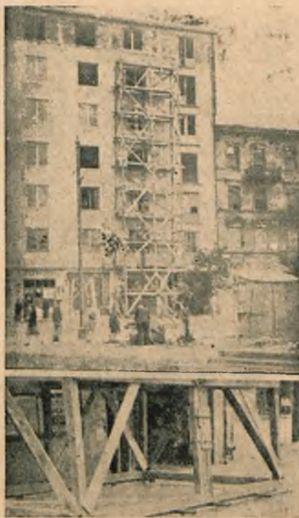
Fig. 3. Wieże drewniane przesuwne zastosowane przez firmę Przeclawski i Wojciechowski przy wykonaniu fasady kamiennej budynku przy ul. Puławskiej Nr. 2 U dołu podstawa wieży w zbliżeniu.
