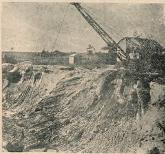
Fig. 10. Draglajn przy pracy.
