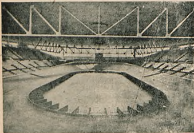
Fig. 1. Widok na wewnątrz stadionu w Zurychu. Na zdjęciu widoczne: tor kolarski, trybuny, łoże wewnątrz toru, i konstrukcja dachowa. Stadion jest największą tego rodzaju konstrukcją w Europie.
