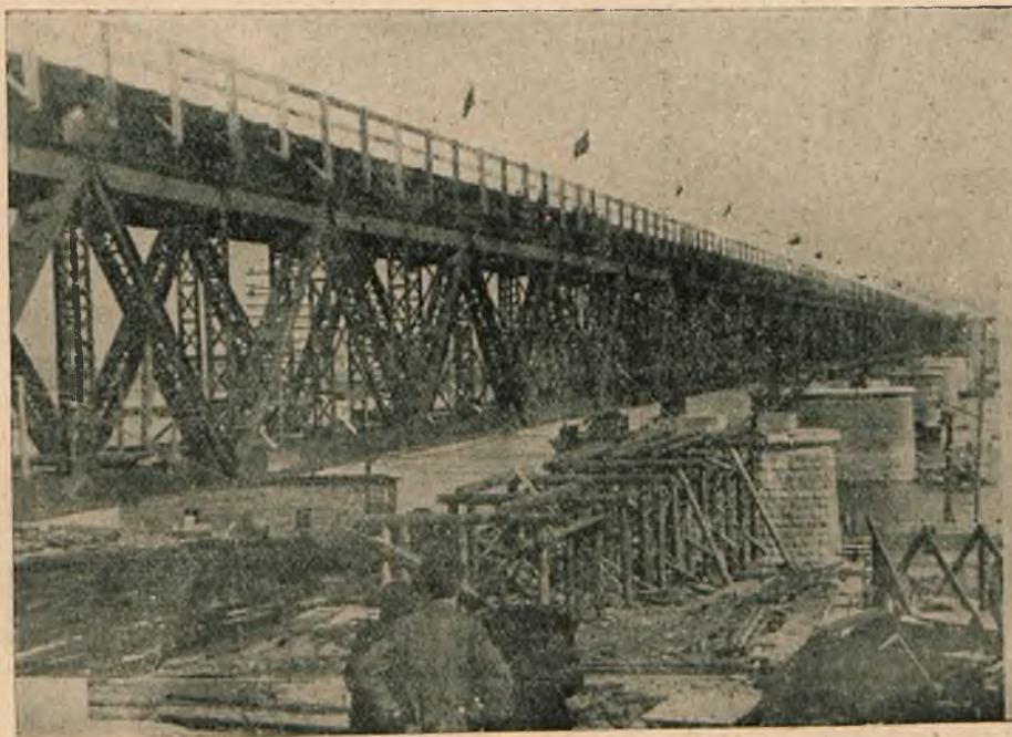
Fig. 5. Widok mostu w dniu otwarcia (19 marca 1946 r.).
