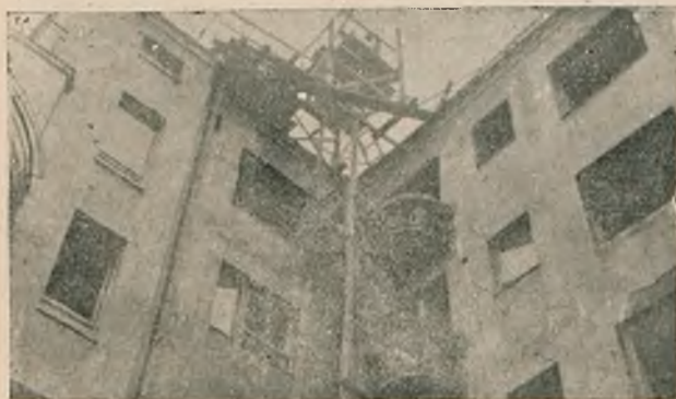
Fig. 2. Widok na konstrukcję pomostu wyciągowego windy drewnianej.
