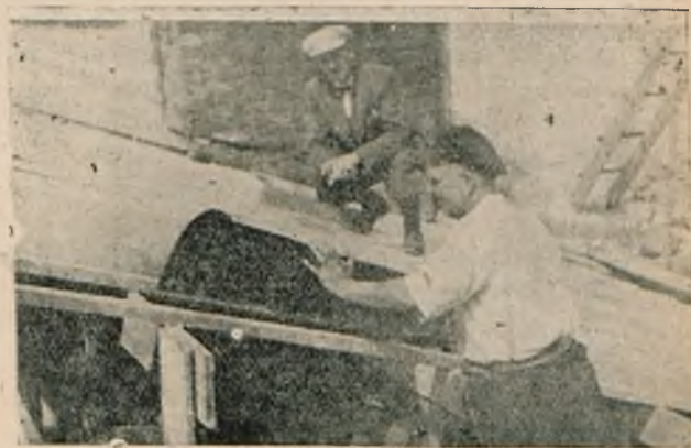
Rys. 2. Zakładanie blachy duralowej przy wykonywaniu deskowania dachu żelbetowego syst. „Monolit”.
