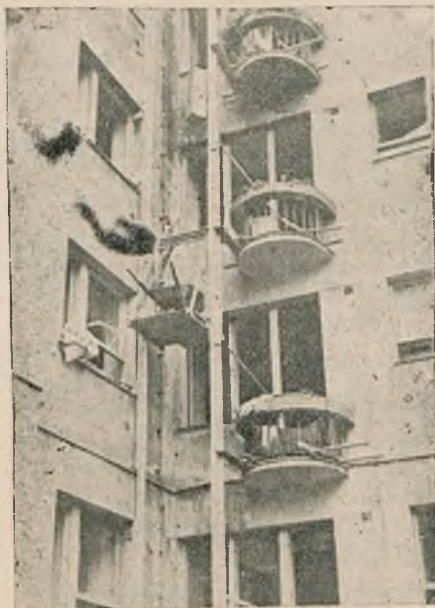
Fig. 1. Prymitywna winda drewniana. Klatkę z taczka wciąga się do góry między dwoma prowadnicami drewnianymi. Nad klatką widoczna przeciwwaga, uwieszona na drugim końcu liny stalowej.
