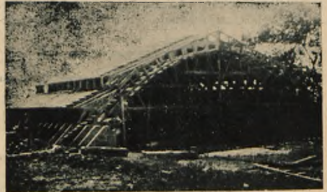
Fig. 6. Montaż więźarów konstrukcji dachowej hali fabrycznej z lekkiego betonu drewnianego (Bytom). Rozpiętość 16,00 m. Montaż poszczególnych elementów więzara odbywa się na przesuwnych krążkach drewnianych.
