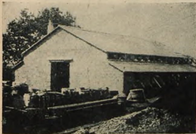
Fig. 8. Gotowa hala z fig. 6. Ściany z pustaków żużlobetonowych, konstrukcja dachowa z elementów z lekkiego betonu, pokrycie dachowe z płyt lekkobetonowych z gładzią cementową szczerłą.
