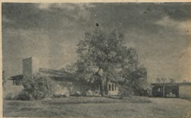
Fig. 4. Dom ten, zbudowany na wzgórzu na brzegu Pacyfiku (stan Kalifornia), jest typowym domem, spotykanym w ciepłym klimacie południowej i zachodniej strefy Stanów Zjednoczonych. Całość na jednym poziomie nosi na sobie piętno dawnej hiszpańskiej architektury, przystosowanej do tych okęgów.
