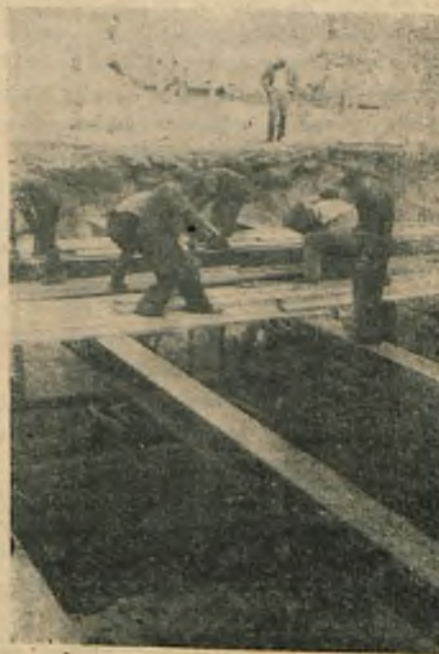
Rys. 4. Moment podnoszenia płyty.
