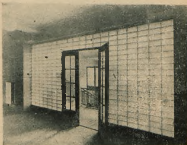
Rys. 1. Drzwi w ścianie z cegieł szklanych.
