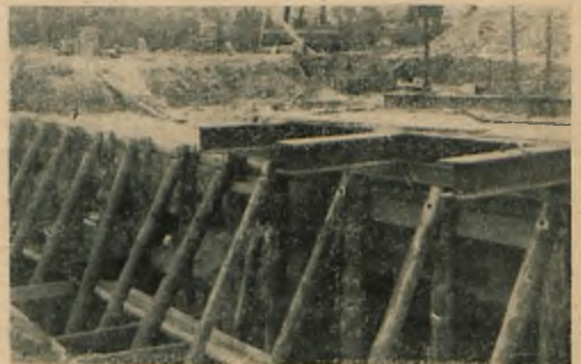
Rys. 2. Zmontowana konstrukcja podnosząca.
