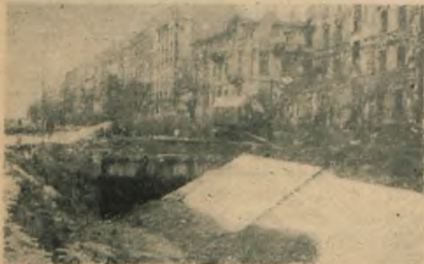
Rys. 1. Zawałone płyty tunelu
