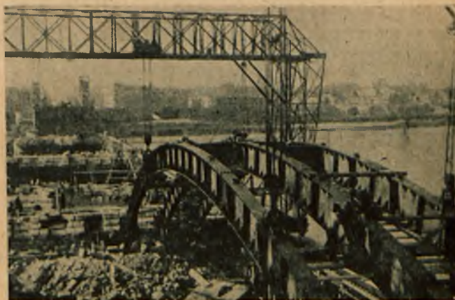
Rys. 8. Ustawianie na łożyskach pierwszych łuków przęśla.
