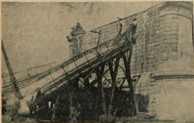
Rys. 1. Zwały zburzonego mostu.
