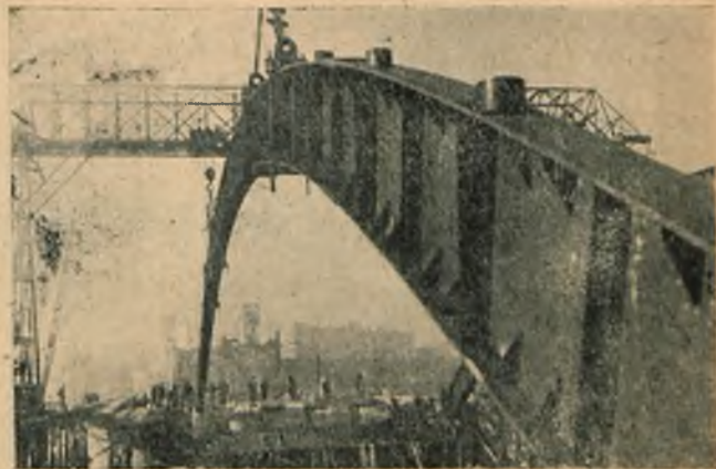
Rys. 7. Łuk unoszony do góry przez kran portalowy.
