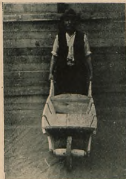
Fig. 5. Taczki drewniane z fig. 4. Charakterystyczne małe, wygodne nie męczące robotników rozchylenie uchwyty. Zdjęcia z jednej z budowli firmy „Arch. F. W. Dawn — Katowice” ).
