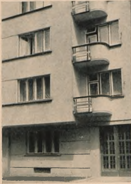
Fig. 3. Wykusz w domu szkieletowym o schemacie wg fig. 1a. Doskonały stan wyprawy.
