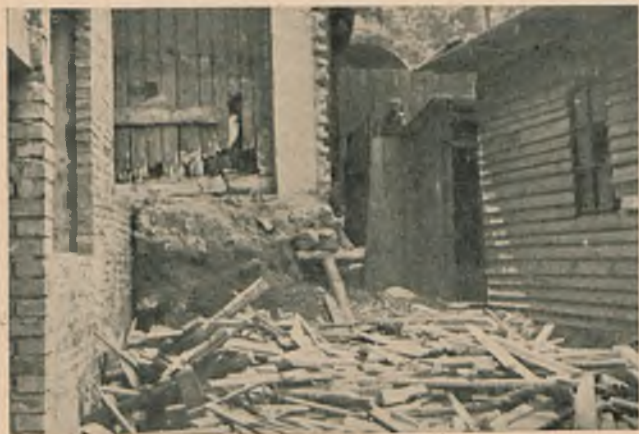
Fig. 2. Widok na „przeście” dla robotników do ustępu i baraku.
