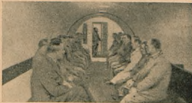
Rys. 15. Wnętrze schronu fabrycznego z rur betonowych.
