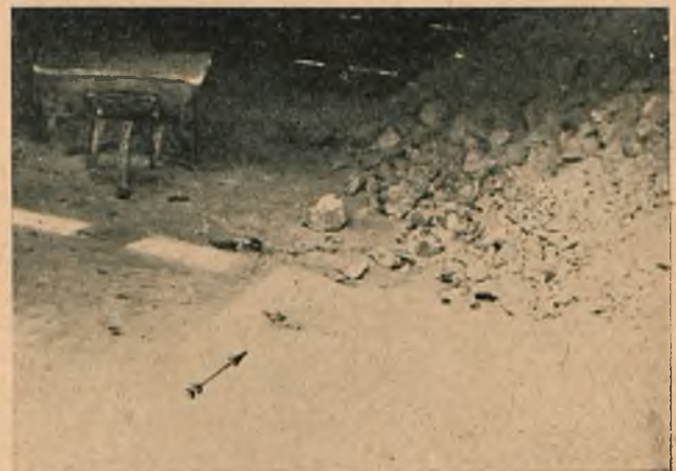
Fig. 2. Pożar od lasującego się wapna powstał najpierw w podłodze szopy, pod zwalami wapna.
