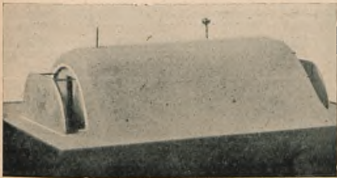
Rys. 24. Schron z blachy falistej Muirheada model.
