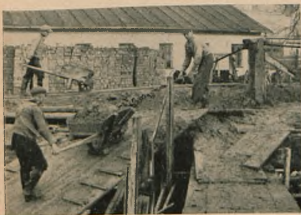
Fig. 3. Taczki drewniane o pojemności 150 l do robót ziemnych. Widoczne odcciążające szelki, które nosi robotnik kierujący taczka. Charakterystyczne duże rozchylenia uchwyty taczki.
