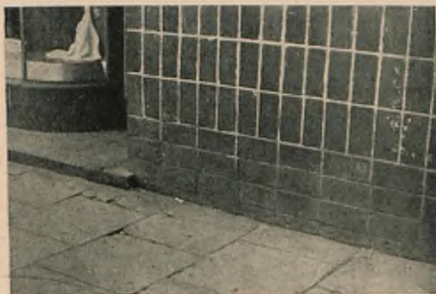
Fig. 2. Licówka cokołu w klinkierze na „płask”.
