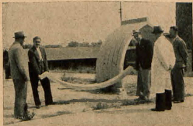
Fig. 3. Elementy żelbetowe służące do budowy schronów są bardzo lekkie, — dwóch ludzi z łatwością wykonywa wszelkie manipulacje tymi elementami.
