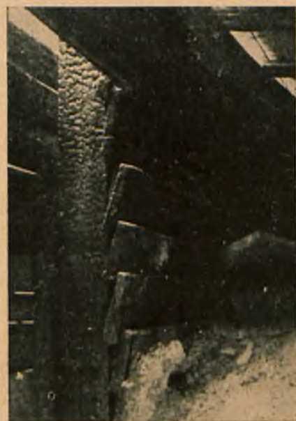
Fig. 3. Zetlane części ścianek szopy.
