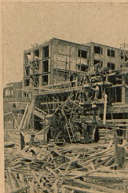
Fig. 1. Widok na plac budowy z zainstalowaną betoniarką i pomostami do pocztowania betonu. fot. W. B.
