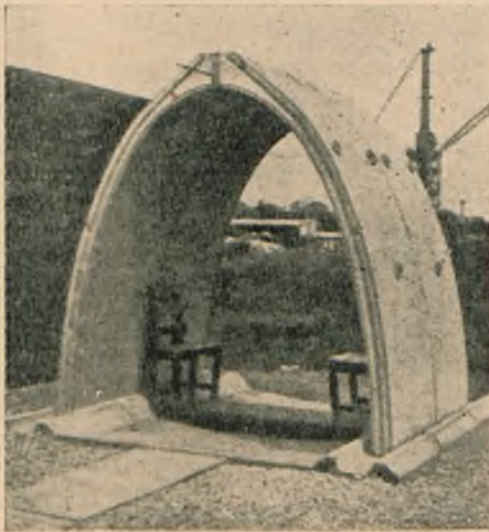
Rys. 20. Schron betonowy ostrolukowy (przekrój odcinków teowy).
