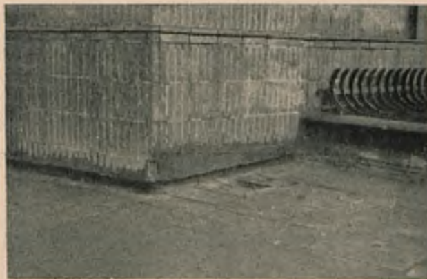
Fig. 1. Licówka w klinkierze układanym „wozówką”. Widoczna słaba odporność licówki na wpływy atmosferyczne.
