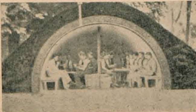
Rys. 21. Schron z blachy falistej.
