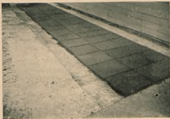
Rys. 12a. Warstwy izolacyjne dolnej podłogi grzewczej alfol i korek. (fot. inż. arch. St. Fischera).
