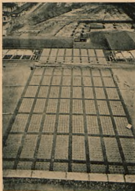
Rys. 8. Świetlik szkłożelbetowy, gotowy. Widok z góry (fot. inż. St. Fischer).
