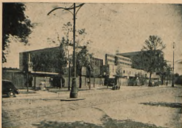
Rys. 1. Dworzec w budowie. Widok z ulicy Aleje Jerozolimskie (fot. inż. St. Fischer).
