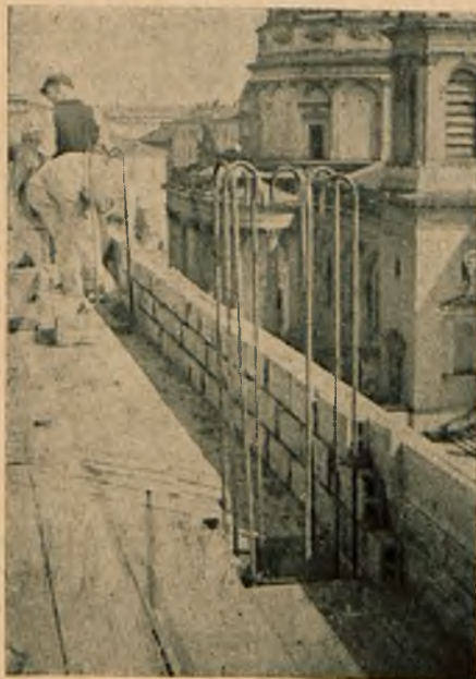
Fig. 1. Układanie izolacji z cegiel - dziurawek na licu zewnętrznej belki w szkielecie żelbetowym.
