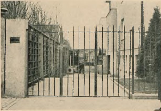
Rys. 1. Brama o niesymetrycznych skrzydłach. Zgrubienie lewe (słupek skrzydła bramy) maskuje niesymetryczność bramy. Pręty bramy pionowe — bez prętów poziomych utrudniają ewentualne wdrapanie się złodzieja. Interesujące umieszczenie skrzynki na listy — zabezpieczonej całkowicie przed zaciekaniem w lewym betonowym słupku bramy.
