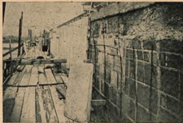
Rys. 11. Licowanie kamieniem na zbrojeniu (fot. inż. St. Fischer).
