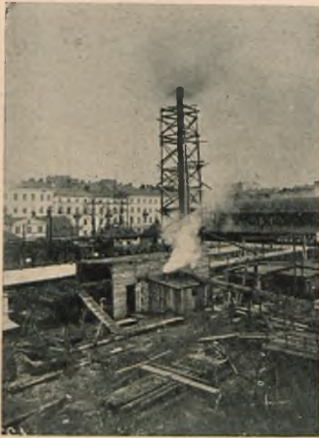
Rys. 3. Stara lokomotywa jako źródło ciepła dla robót prowadzonych w zimie (fot. inż. St. Fischer).
