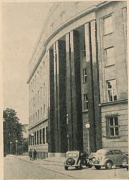
Fig. 1. Słupy portalu Izby Przemysłowo-Handlowej w Warszawie wykonane w polerowanym granicie Zdzilów.
