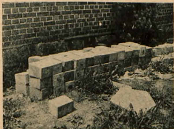
Fig. 2. Gotowe do wmurowania sześciaki betonowe z klockami.
