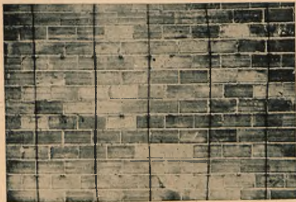
Rys. 10. Zbrojenie ściany pod licówkę kamienną (fot. inż. St. Fischer).
