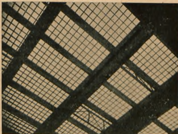
Rys. 9. Świetlik szkłożelbetowy. Widok z dołu (fot. inż. St. Fischer).
