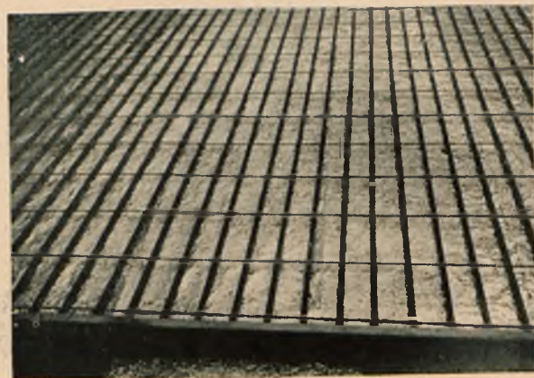
Rys. 12b. Podłoga przed zabetonowaniem. Warstwa alfolu, na tym rurki dla kabla grzewczego przewiązane drutem rozdzielczym. (fot. inż. arch. St. Fischera).
