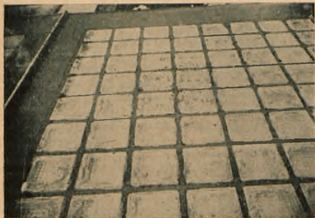
Rys. 6. Świetlik szkłożelbetowy. Widok po zabetonowaniu foremek bakelitowych (fot. inż. St. Fischer).
