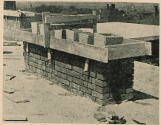
Fig. 1. Deskowanie czapki betonowej komina z cegły licowej; deskowanie podtrzymują haki ze stali Griffel. Dusze (rdzenie) służące do uformowania otworów lekko ostrosłupowe w celu łatwego wyjęcia po stwardnieniu betonu. Ściągacz deskowania zbitý z desek w sposób zapewniający należyłą jego sztywność.
