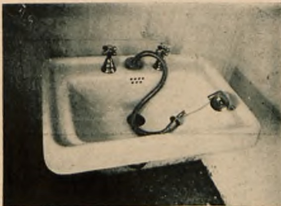
Rys. 6. Umywalka do stanowiska fryzjerskiego. Wąż wysunięty. (fot. inż. Fischer).
