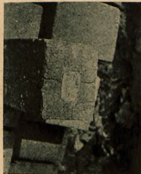
Fig. 5. Kłoczek o wadliwym układzie słołów i niedostatecznie terowany rozszedł sześciak betonowy.
