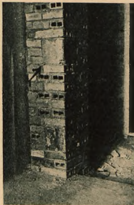
Fig. 3. Sześciak betonowy z fig. 1 wmurowany w otworze drzwiowym.
