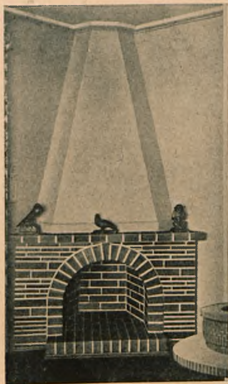
Rys. 4. Kominek klinkierowy. Efektowne jasne spoinowanie.
