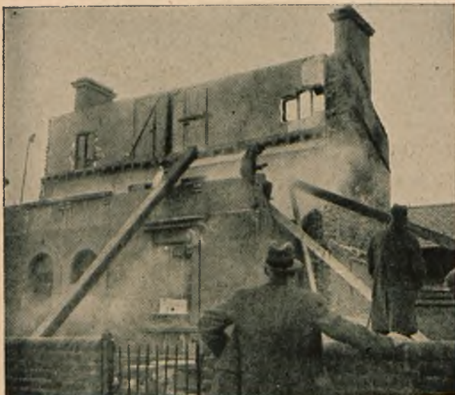
Fig. 4. Próba wytrzymałości schronów piwnicznych przez burzenie domu przy pomocy bomb lotniczych. Widoczne słupy drewniane podtrzymujące z zewnątrz ściany dla zmuszenia ich do zawalenia się do wnętrza.
