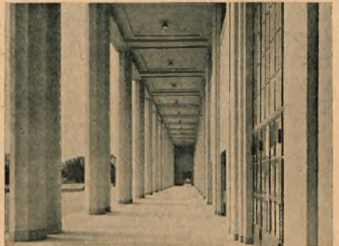
Fig. 14. Podcień w Parku Sportowym w Marsylii. Dzięki użyciu dykty do deskowań otrzymano pięknie wykończoną surową powierzchnię betonu.
