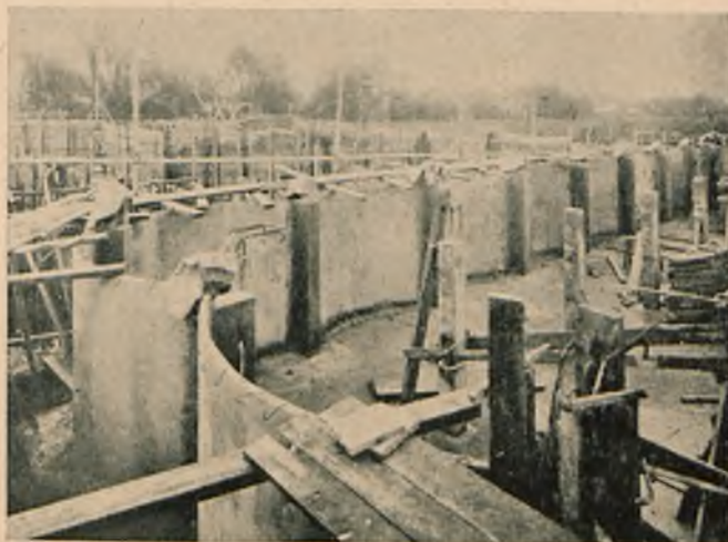
Fig. 10. Zbiornik wody zagłębiony w ziemi w Aulnay-sous-Bois. Poszczególne walcowe ściany zostały wykonane jednym i tym samym deskowaniem przenośnym.
