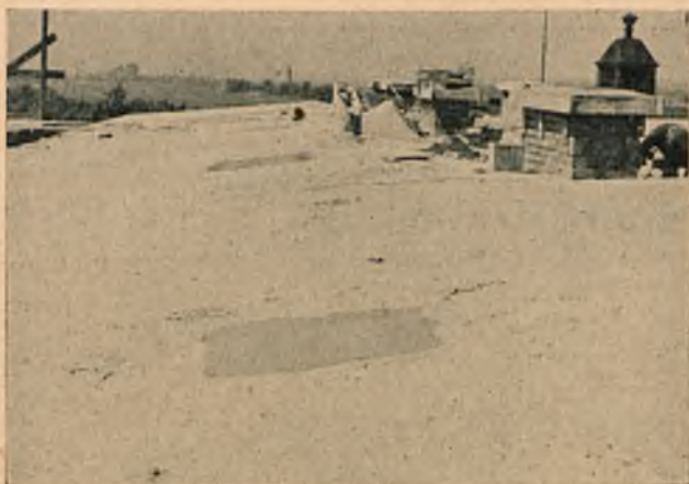
Dach żelbetowy płytowy kryjący poddasze nieużytkowe. Widoczne przed chwilą zabetonowane prowizoryczne wylazy, służące do ułatwienia układania polepy na najwyższym stropie. Zdjęcie z budowy gimnazjum państw. w Rudzie Śl. wykonywanego przez F-mę T. Torentz, Katowice.
