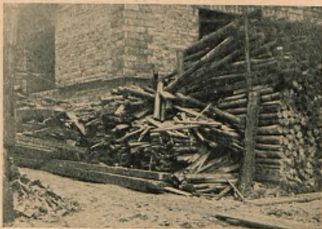
Rys. 2. Odpadki drzewne skrupnie się zbiera na budowie, sortuje i układa w porządku.
