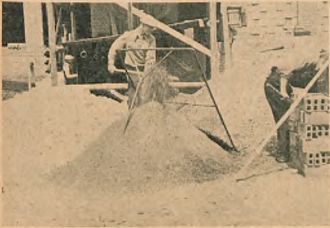
Rys. 1. Rafa do odsiewania żwiru z siatki rozpiętej na ramie z prętów żelaznych okrągłych.
