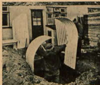
Fig. 2. Układanie pokryw z blachy falistej schronu Andersona.
