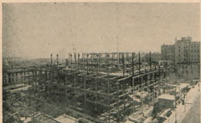
Montaż konstrukcji stalowej.
