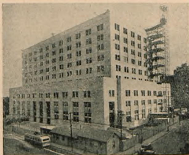
Budynek ukończony po 6 miesiącach.
