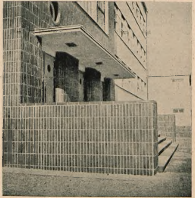
Rys. 8. Tak nie należy układać klinkieru — rysunek odznacza się nużącą monotonią (dom w Warszawie).
