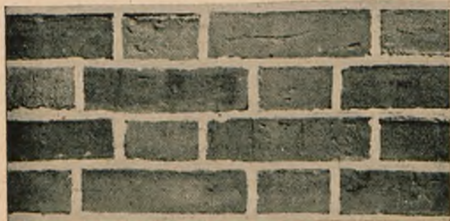
Rys. 1. Charakterystyczny angielski mur ze zwykłej cegły. Cegły o różnych kolorach i odcieniach, lagodzonych i wyrównanych białym spoinowaniem.
