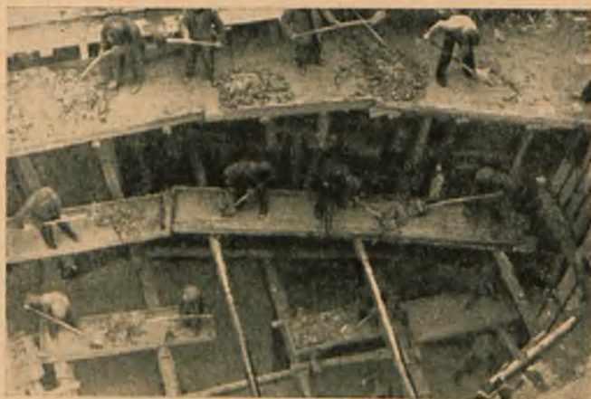
Transport pionowy ziemi z dołu fundamentowego o głębokości 15 m od naziomu. Ściany dołu zabezpieczone przed osuwaniem się ścianką szczelną ze szpuntali stalowych Larssena. Zdjęcie z robót F-my Inż. K. Goryjanowicz, Katowice, przy budowie Muzeum Śląskiego.
