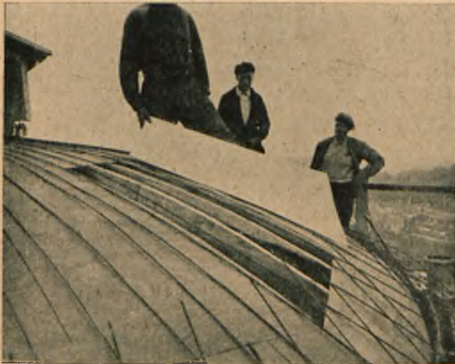
Fig. 12. Kopia w Szpitalu Morskim w Rochefort-sur-Uler. Dla pokazania konstrukcji deskowania odsłonięto jeden płat dykty.
