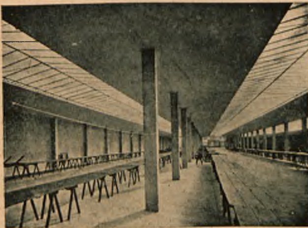
Fig. 2. Hala targowa w Bobigny (Francja). Przez użycie deskowania obitego dyktą uniknięto potrzeby tynkowania stropu.
