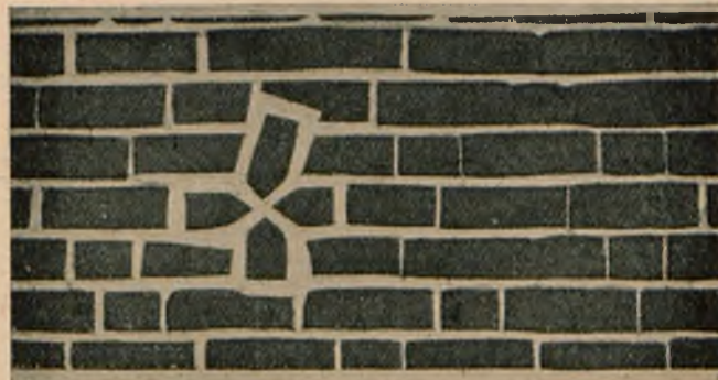
Rys. 2. Ciekawy fragment muru Stadshuset w Sztokholmie i sposób wiązania cegieł i ozdoby.
