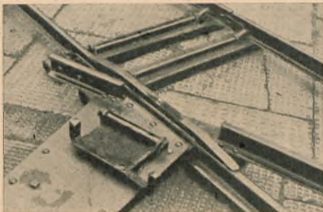
Rys. 10. Zwrotnica nakładana w pozycji do jazdy wprost.
