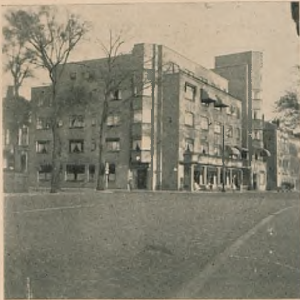
Rys. 4. Dom mieszkalny w Hadze licowany cegłą zwykłą licówką.
