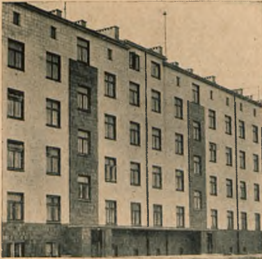
Rys. 10. Elewacja budynku w Dęblinie licowana płytami cementowymi.
