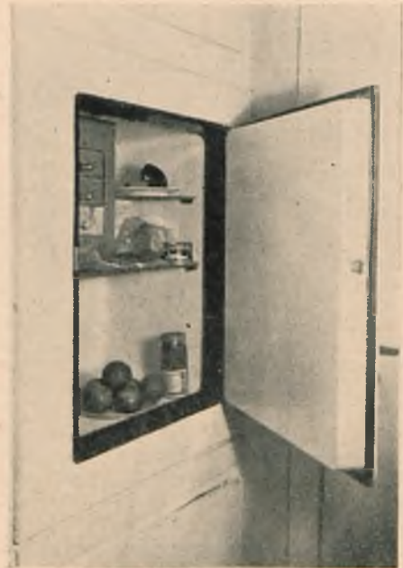
Rys. 2. Szafa w inst. centralnej wbudowana w niszę ścienną. Pojemność 90 litr.
