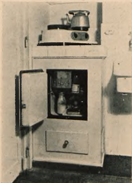
Rys. 3. Szafa w inst. centralnej wbudowana częściowo w niszę. Pojemność 50 litr.
