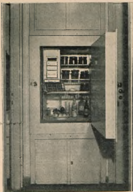
Rys. 5. Szafa w inst. Centralnej. Pojemność 250 litr.
