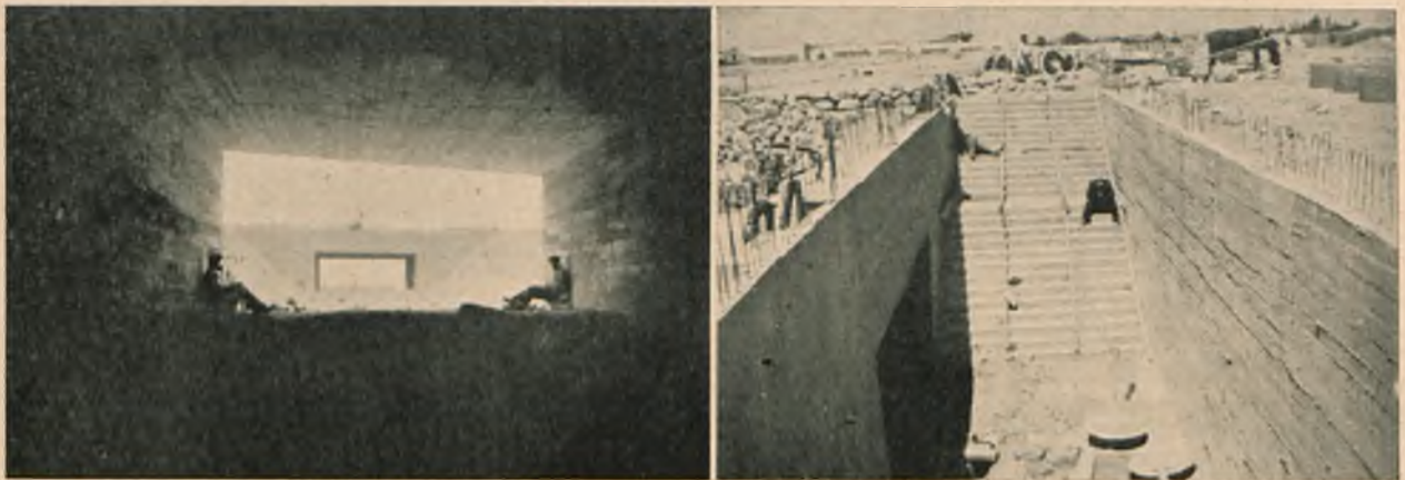
Fig. 38. Tunele dla ruchu pieszego pod jezdnią dla samochodów. 1) Włok dolnej części tunelu — w głębi drugi tunel. 3) Widok na schody prowadzące do tunelu w stanie surowym.
