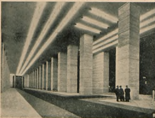
Fig. 4. Widok wnętrza galerii honorowej wieczorem; zwraca uwagę oświetlenie za pomocą rur betonowych.
