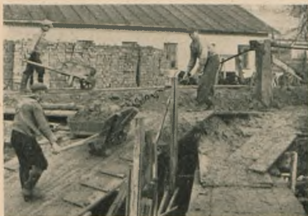
Fig. 1. Transport pionowy ziemi z wykopu przy pomocy taczek o ładowności 0,180 m 3 po pochylni drewnianej. Taczki są podciągane po pochylni przy pomocy sznura przerzuczonego przez blok, ciągniętego przez zaprzęg konny (fig. 2). Pochylnia zabezpieczona jest przed poślizgiem robotnika schodzącego z pustą tawką względnie w celu ułatwienia w ogólności komunikacji, nabitymi na pochylnię latami drewnianymi.
