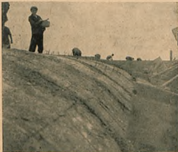
Fig. 30. Krycie dachu trybuny II miejsc płytami izolacyjnymi z wełny drzewnej — „Suprema”. Fot.: — inż. arch. Z. Plater-Zyberk.
