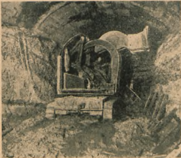
Fig. 1. Kopaczka do robót podziemnych i fundamentowych. Widać dobrze oryginalnie wygięte ramię kopaczki.
