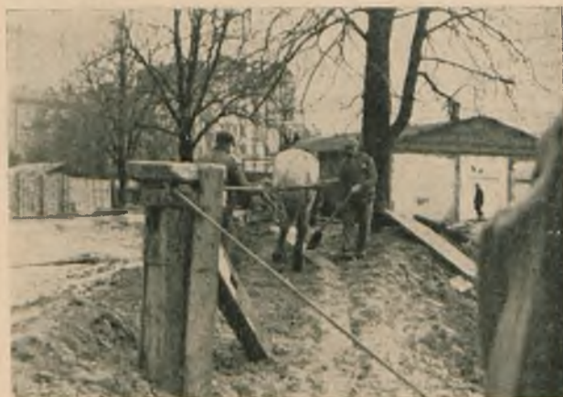
Fig. 2. Na zdjęciu widuć linę przerzuczoną przez blok i ciągnięną przez zaprzęg konny.
