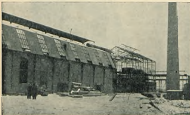
Nowe hale fabryczne żelbet. w Zakładach „Hohenlohego” w Welnowcu
