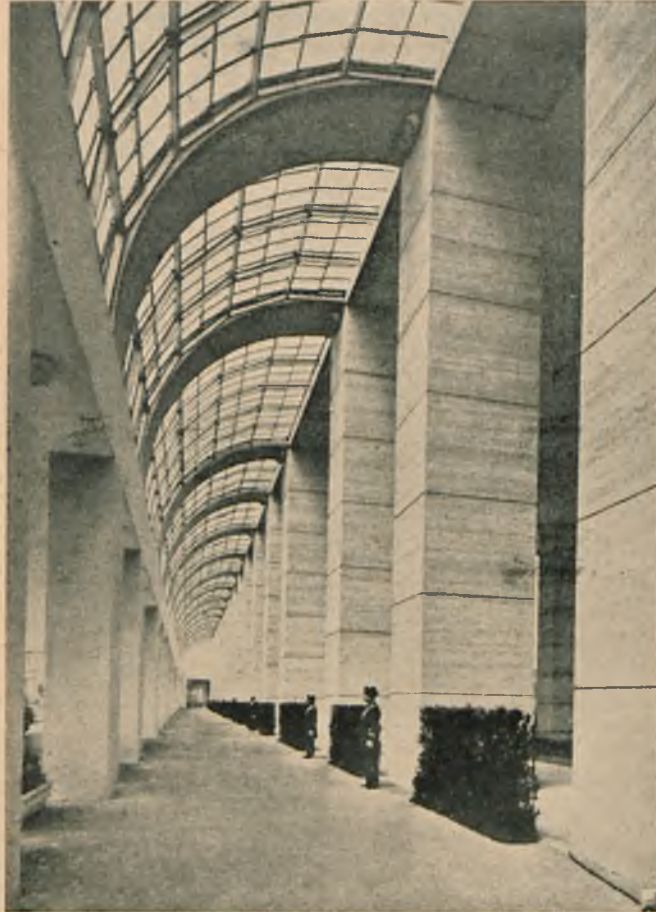
Fig. 3. Widok wnętrza galerii przykrytej półłukiem.
