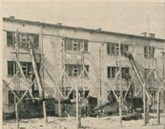
Osuszanie budynku T. O. R. w Warszawie.
