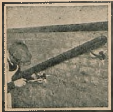
Rys. 1. Mocowanie poręczy metodą Rawlplugs.
