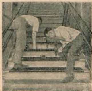
Rys. 6. Mocowanie okładzin schodowych.
