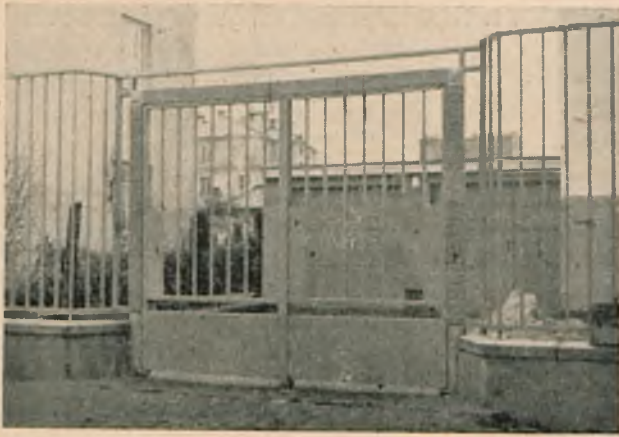
Fig. 3. Brama żelazna z zamkiem jednodźwigniowym z dźwignią umieszczoną z tyłu bramy. Dźwignię można otwierać lub zamykać po przekręceniu klucza w zamku przez sięganie ręką po pionową kratę bramy.
