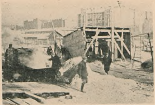
Fig. 3. Z lewej strony dwa zbiorniki do podgrzewania wody, w głębi większy obudowany, bliżej mniejszy nieosłonięty. Na prawo betoniarka osłonięta deskowaniem, uszczelnionym od wiatru przybitymi workami papierowymi po cemencie.
