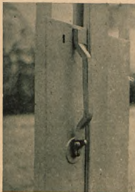
Fig. 1. Zamknięcie żelaznej bramy przy pomocy zamku jednodźwigniowego.
