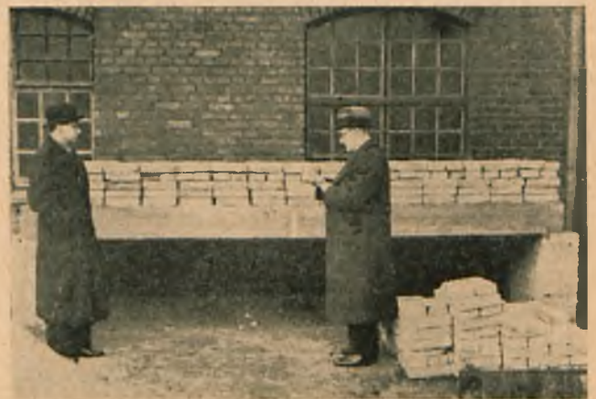
Rys. 6. Ciężar własny i użytkowy ok. 4000 kg — Ugięcie 5 mm.
