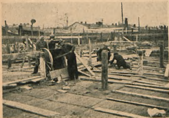
Fig. 7. Wsypywanie betonu do leja; widać dobrze uszczelnienie otworu przy pomocy papy.
