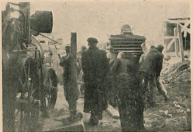
Fig. 4. Maszyny pomocnicze używane na budowie. Z lewej strony lokomobila, z prawej maszyna do ogrzewania powietrza, na pierwszym planie kosz z koksem dla obsługi maszyn.
