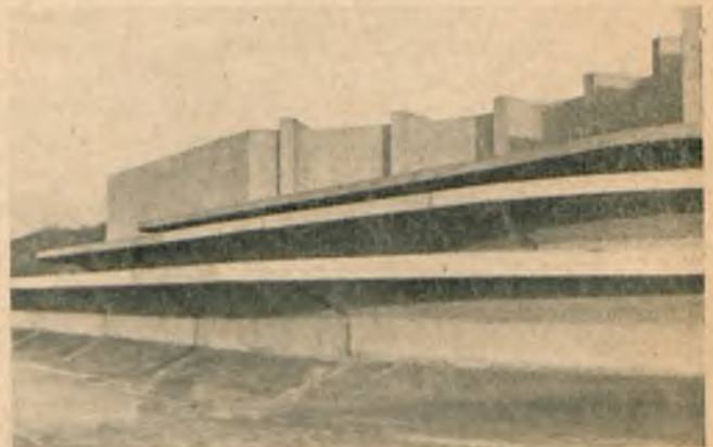
Rys. 8. Kaskada wykonana z gotowych elementów żelbetowych.
