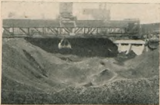
Elektrownia Warszawska. — Uszczelnienie dołu węglowego.
