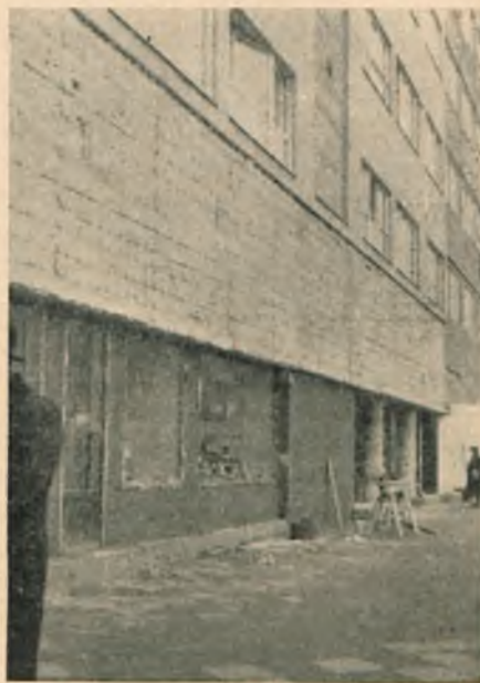
Fig. 1. Fasada domu kryta płytkami szklanymi na zaprawie cementowej.
