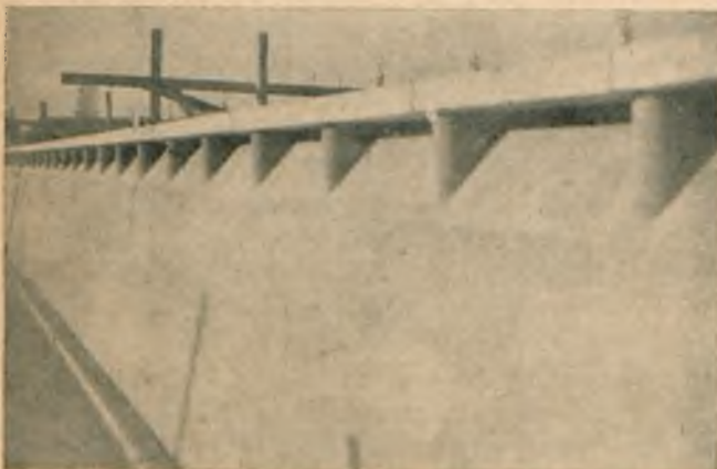
Rys. 6. Widok ścian bocznych po wykonaniu.
