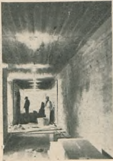
Izolacja tunelu na dworcu kolejowym.
