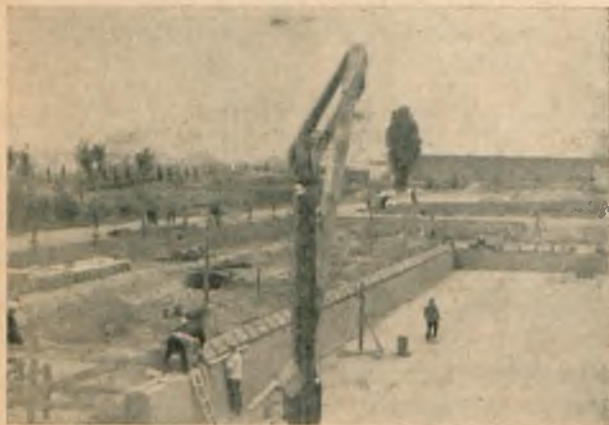
Rys. 5. Układanie elementów ukośnych na murach oporowych.
