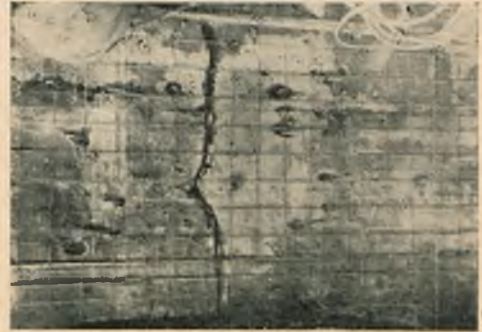
Naprawa pęk. fil. most. zaprawą cement. z Tricosalem S III.
