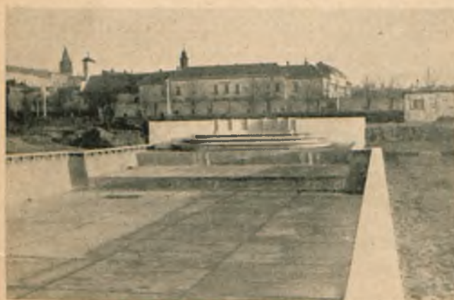
Rys. 11. Basen widziany od strony zachodniej.
