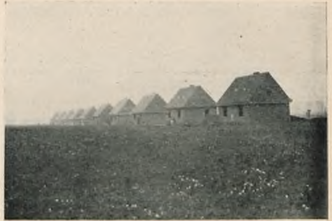
Fig. 4. Nowowzniesione osiedle dla bezrobotnych w Tczewie. Grupa 10 domków wzniesiona została w sposób standaryzowany, dzięki czemu obniżono koszty do ostatecznego minimum.
