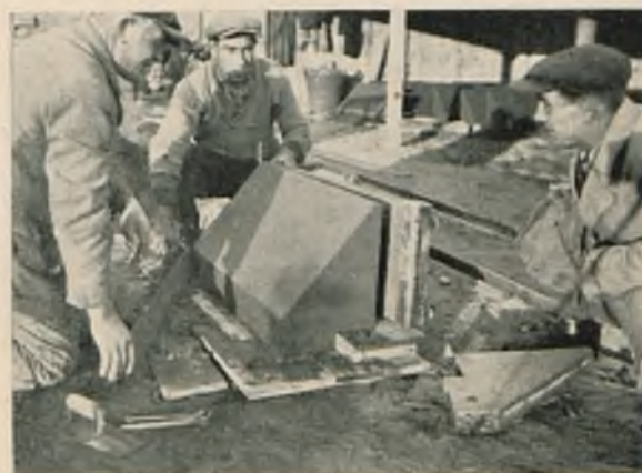
Rys. 3. Rozszalowanie ukośnego bloku betonowego.
