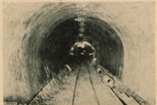
Izolacja tunelu drogowego produktami Tricosal.
