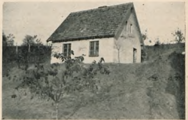
Fig. 5. Jeden z domków osiedla dla bezrobotnych w Chełmnie na Pomorzu. Osiedle w Chełmnie rozrzucone jest w bardzo malowniczej okolicy podmiejskiej.
