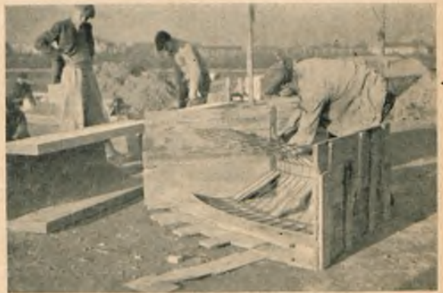
Rys. 7. Elementy żelbetowe służące do wykonania kaskad. Montaż żelaza. Z lewej strony gotowy element.
