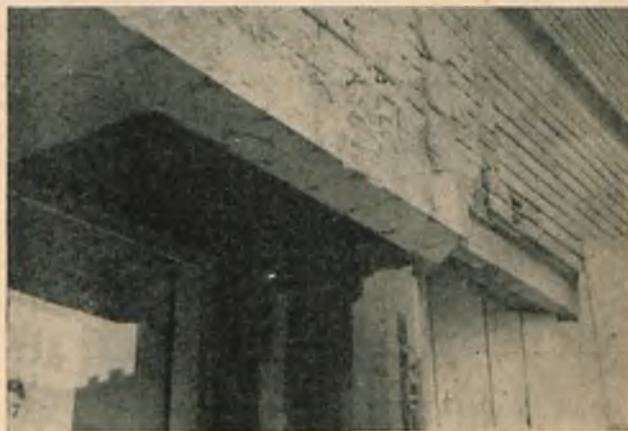
Fig. 2. Szczegół fasady z fig. 1. Widać jeszcze część płytek przylegających do ściany i słupa szkieletu.
