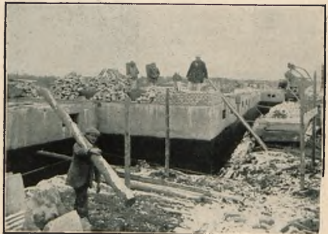
Izolacja fundamentów kolonii mieszkaniowej Acosalem.
