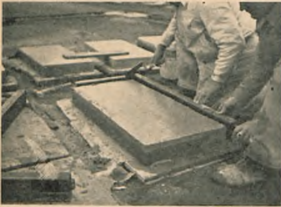
Rys. 4. Wykonanie płyty budowlanej.
