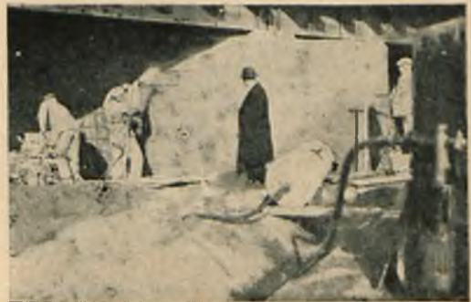
Po wykonaniu naprawy.
