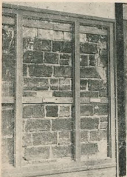
Rys. 32. Wykonywanie boazerii. Widoczne łąty spodnie i przymocowane do nich ramy boazerii.
