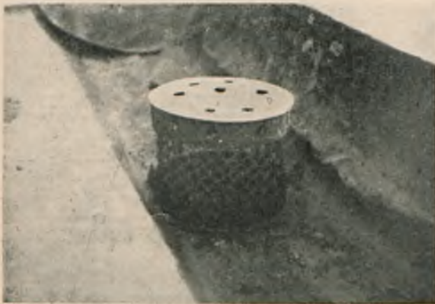
Rys. 20. Koszyczek ochronny nad rurą spustową wewnątrz rynny dachowej.
