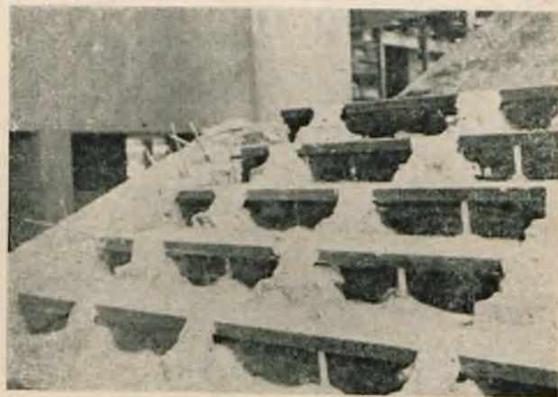
Rys. 36. Wykonywanie wykładziny schodów w szarym granicie polerowanym (płyty stopniowe) oraz marmurze „Dębniak” i „Carrara” (płyty podstopniowe i białe paski działowe).
