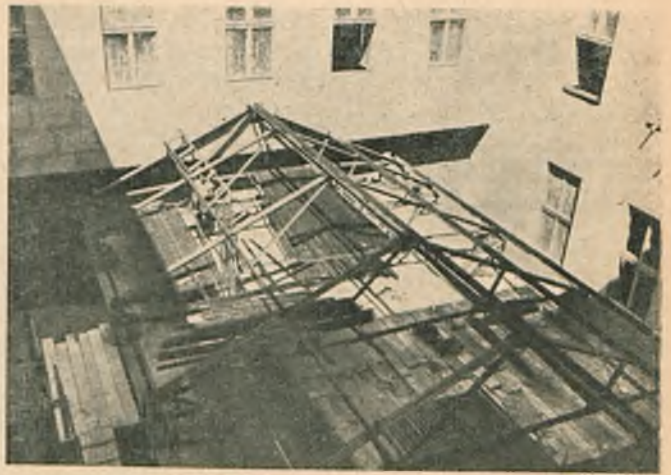
Rys. 38. Montaż konstrukcji świetlika. Widoczne małe nachylenie połaci.
