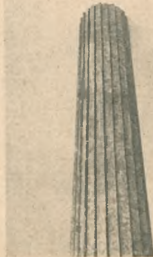
Rys. 25. Kolumna żelbetowa okrągła, wykładana płytkami marmurowymi „Bolechowice”.
