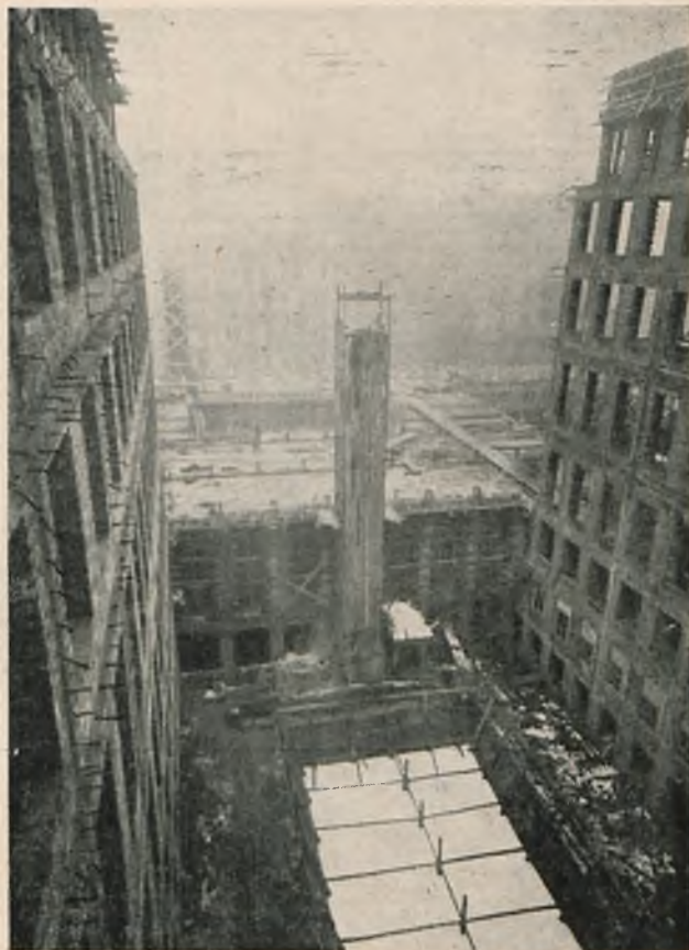
Rys. 12. Szkielet żelbetowy. Widok z okien traktu „I” na dziedzińiec IV i trakt „F”. Ze szkieletu wystają kotwy, zabetonowane łącznie ze szkieletem, służące do podtrzymywania płyt okładzinowych. Prawie całą powierzchnię dziedzińca zajmuje dół z wapnem; obok niego wieża dźwigu budowlanego, w głębi od strony ulicy Leszno widać wieżę paternostra do podawania cegieł itp.
