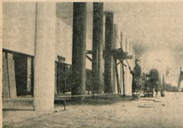
Rys. 37. Wykonywanie zimnej glazury „Heliosol”. W głębi widać robotników spryskujących słupy wodą.
